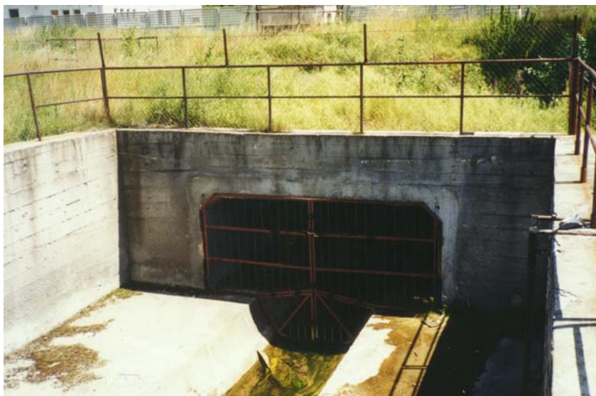
Obr. 5.5.2 Výtok z Novej odvodňovacej štôľne
