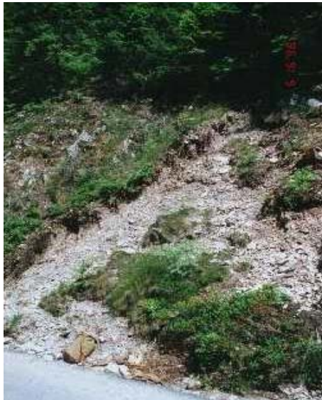
Obr. 5.2.3 Zosúvanie sa trávových drnov po svahových štrkových sedimentoch je najčastejším prejavom spätnej erózie v záreze lesnej cesty nad obcou Osrbliu. Prejavuje sa aj dva roky po rozšírení cesty.
