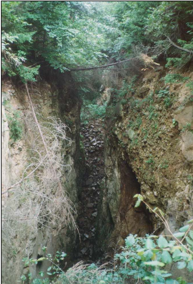
Obr. 5.5.12 Ťahové deformácie povrchu - hlavná trhlina západne od Englišovho lomu, severovýchodne od Cígľa
