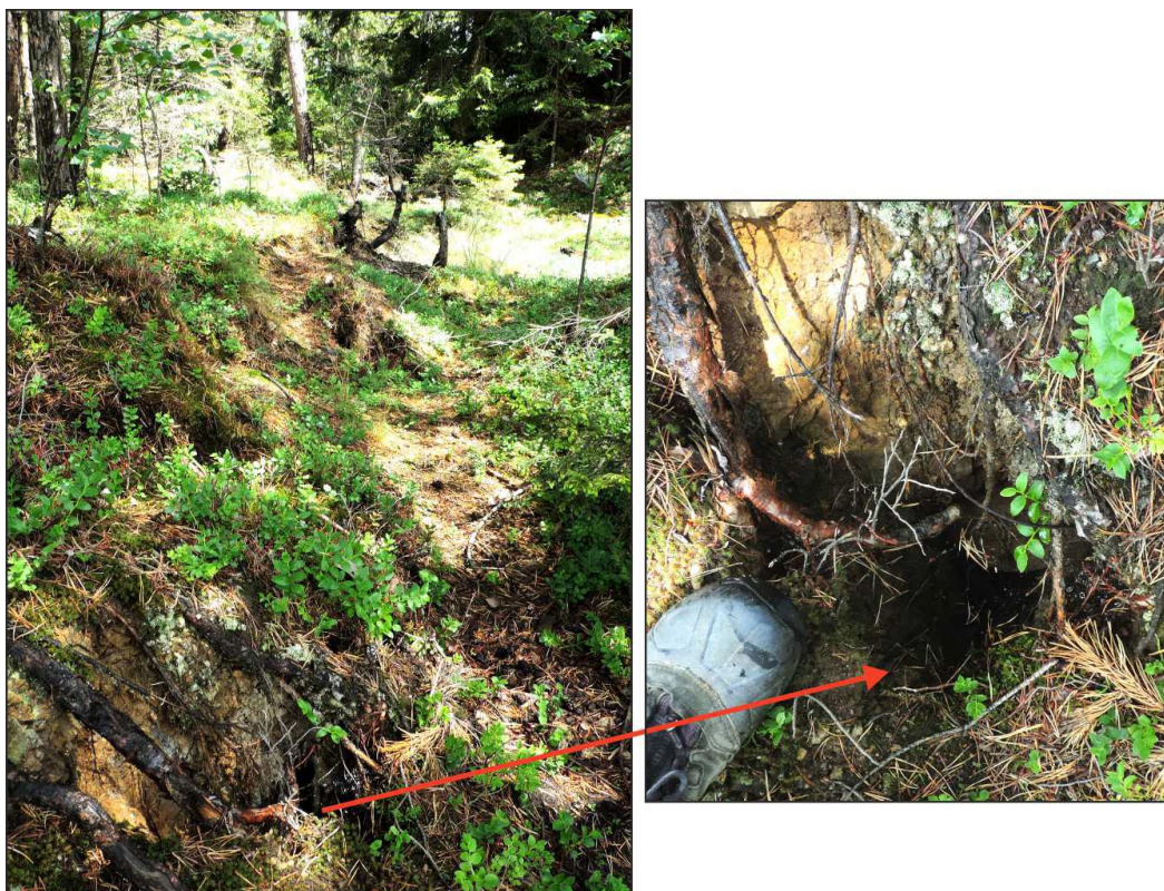
Obr. 4.6.7: Aktivizácia poklesovo – ťahovej trhliny pri stanovišti 1
