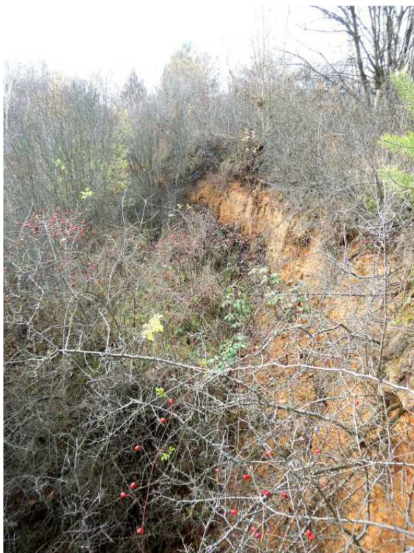
Obr. 4.12.7: Pokles horninového bloku na trhline t6 v r. 2022
