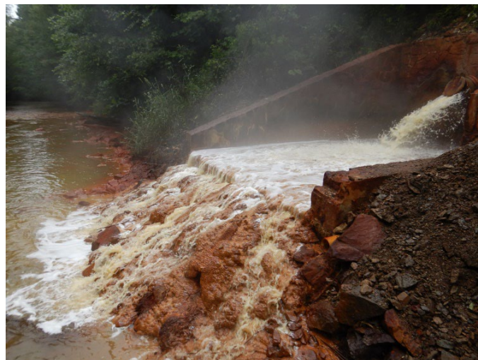
Obr. 4.7.2: Výpustný objekt banskej vody pod ústím štôlne Marta, na pravom brehu rieky Slaná. Z banskej vody sa intenzívne zráža železitý oker
