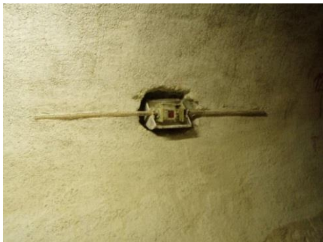
Obr. 28 In-talácia dilatometra TM-71 v únikovej -tôlni tunela Branisko
