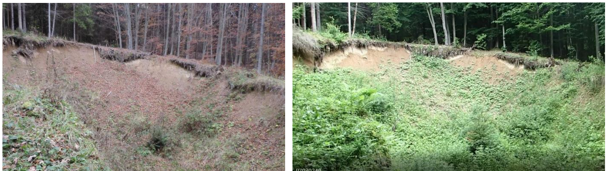
a) b) Obr. 42: Pohľad z JV na hlavný zával na Novej štôlni a) z r. 2014 a b) z r. 2017.
