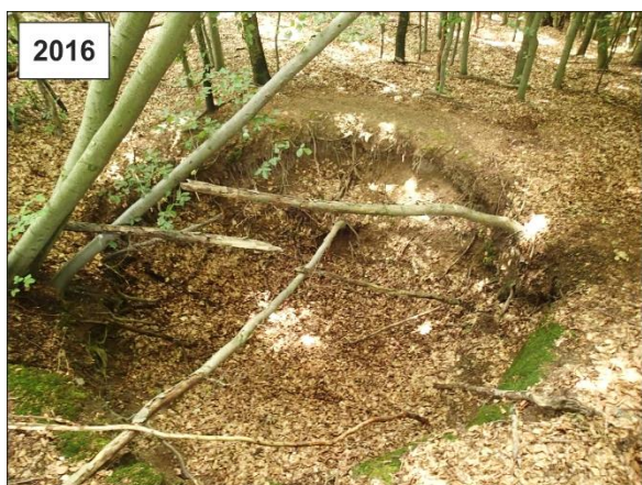
Obr. 10: Aktívny zával Z8 nad banskou chodbou štôlne Rýhová v r. 2016 a 2017 (pohľad zo severovýchodu)
