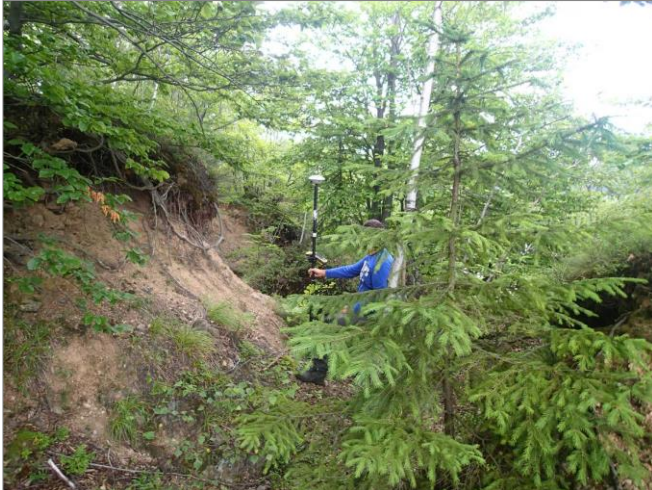
Obr. 27: Trhline tvaru V medzi rozvoľnenými horninovými blokmi
