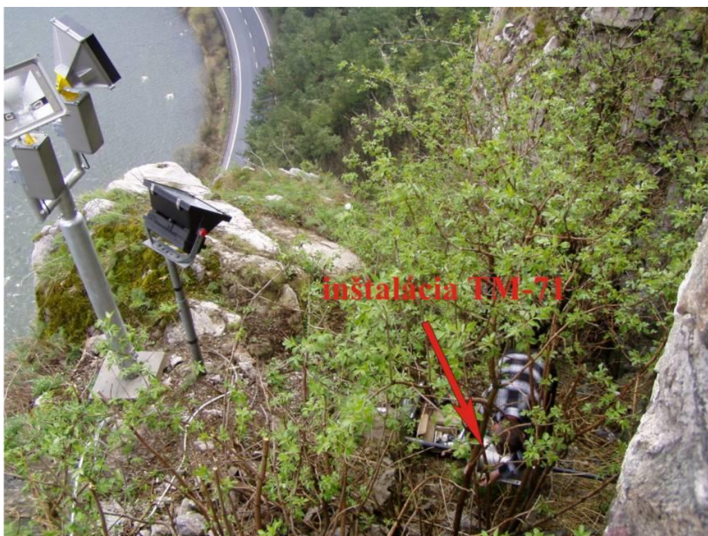
Obr. 22a Pozícia dilatometra TM-71 v trhline pod kaplnkou Strečnianskeho hradu.
