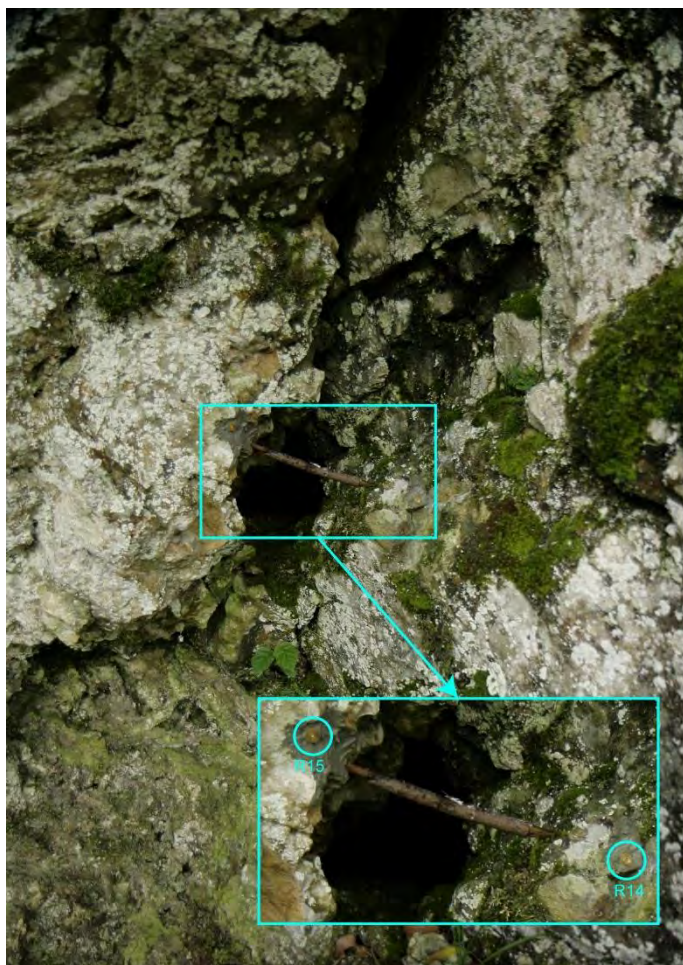
Obr. 4.39.2. Umiestnenie pozorovacích bodov R14 a R15 (Stanovište 2) pre merania dilatometrom Somet na lokalite Pod večným dažďom (Slovenský raj)
