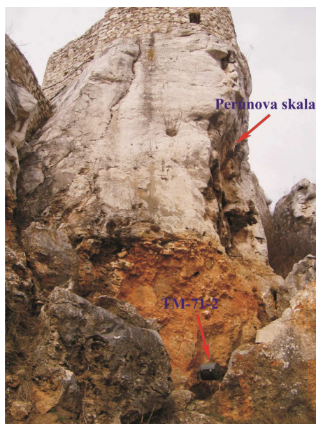
Obr. 10 Inštalácia dilatometra TM 71-2 v trhline pod Perúnovou skalou (vchod do Podhradskej jaskyne).
