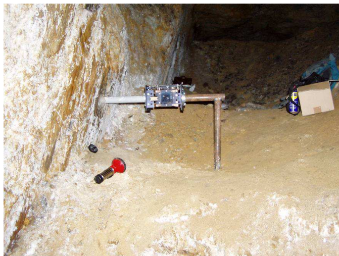
Obr. 21 Inštalácia dilatometra TM-71 v opustenej štôlni Vŕšesvätých (stará) na lokalite Banská Hodruša (Hámre)
