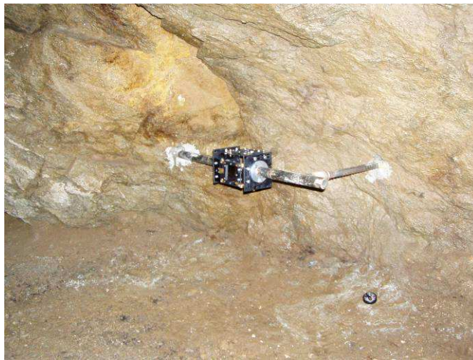
Obr. 22 Inštalácia dilatometra TM-71 v opustenej štôlni sv. Anton Paduánsky na lokalite Vyhne
