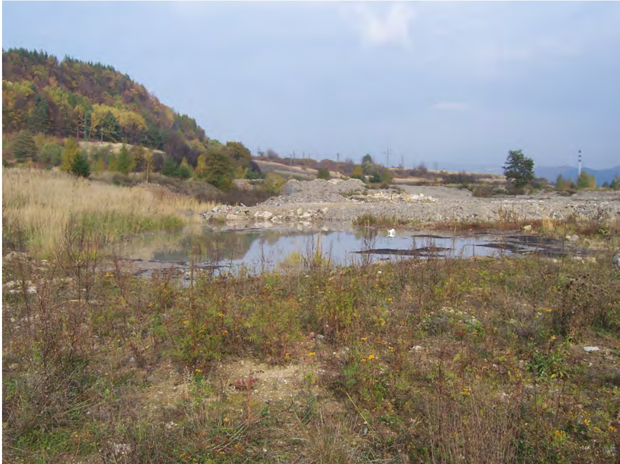
Obr. 1.135 Ukladanie nevhodných materiálov na západnom okraji násypu (neďaleko od vtokového objektu Nepomenovaného potoka) a vytváranie „jazier“ neznámych viskózných látok (foto Z. Nagy, 2008)
