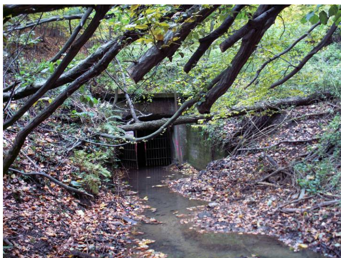
Pyritová štôlna so zátrhmi nad portálom (foto Záhorová, 2009)
