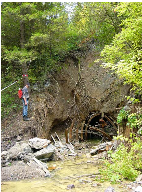
Ústie Novej štôlne po prvom prievale banskej vody. (foto P. Baláž, 2.10.2008)
