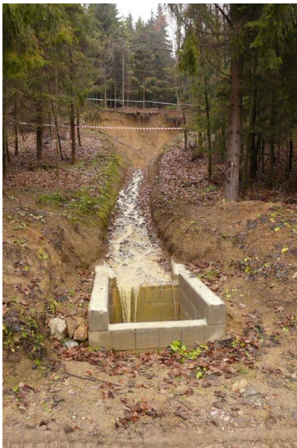
Zával nad Novou štôľňou s prelivom banskej vody. (foto P. Bajtoš, 8.12.2009)
