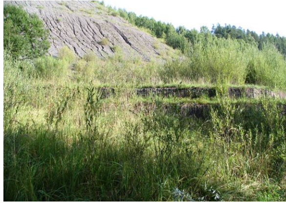
Päta haldy je stabilizovaná, ale povrch haldy nie je chránený pred eróziou (foto Záhorová, 2007)
