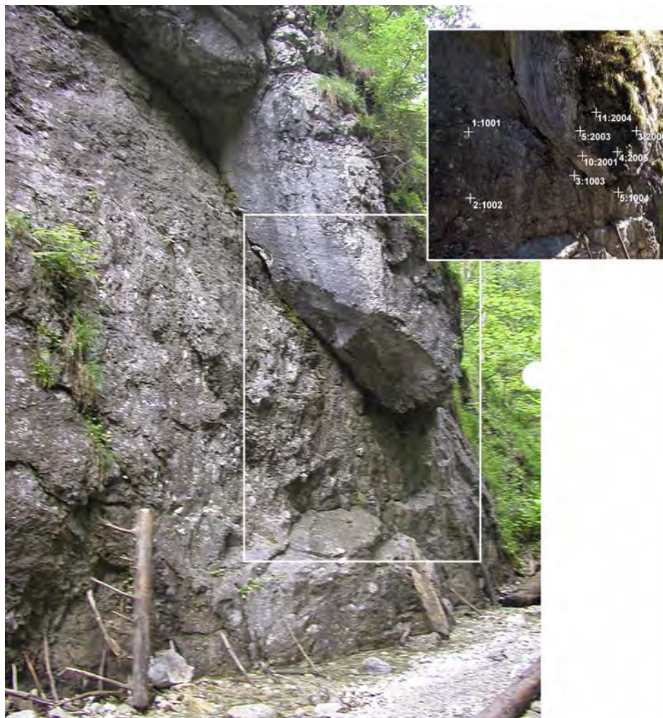
Obr. 2.1.103: Potenciálne nestabilný skalný blok nad turistickým chodníkom v doline Suchá Belá. V detaile je rozmiestnenie vzťažných a pozorovaných bodov pre fotogrametrické snímkovanie
