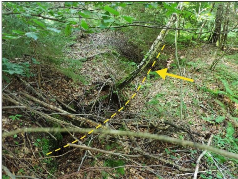
Obr. 4.11.11: Priebeh ťahovej trhliny na dokumentačnom bode 3.
