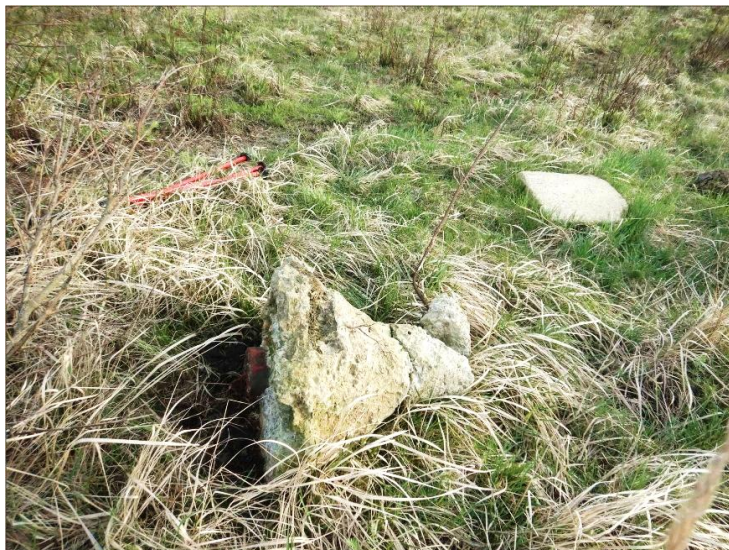
Obr. 4.13.8: Príklad likvidácie meračského bodu.
