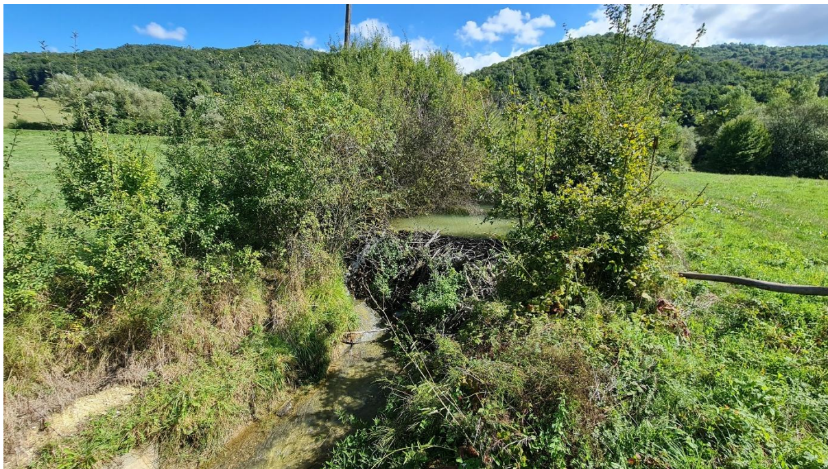
Obr. 4.1.2: Bobria hrádza v odtokovom rigole približne 50 m pod ústím NOŠ pri Voznici.
