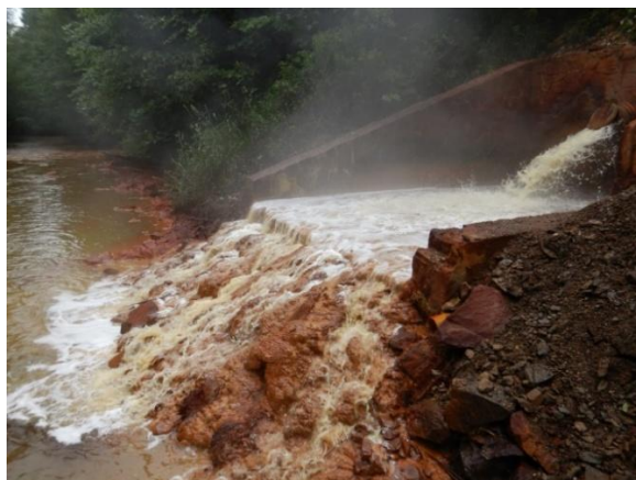
Obr. 4.7.2: Výpustný objekt banskej vody pod ústím štôľne Marta, na pravom brehu rieky Slaná. Z banskej vody sa intenzívne zráža železitý oker.
