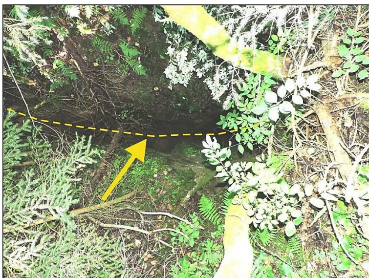
Obr. 4.11.9: Otvorená trhlina v mieste dokumentačného bodu 1.
