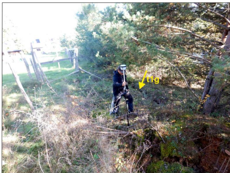
Obr. 4.12.8: Nová ťahovo-poklesová trhlina t1g .
