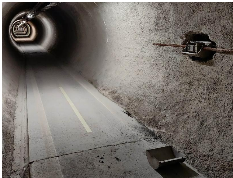
Obr. 35 Inštalácia dilatometra TM-71 v únikovej štólňi tunela Branisko
