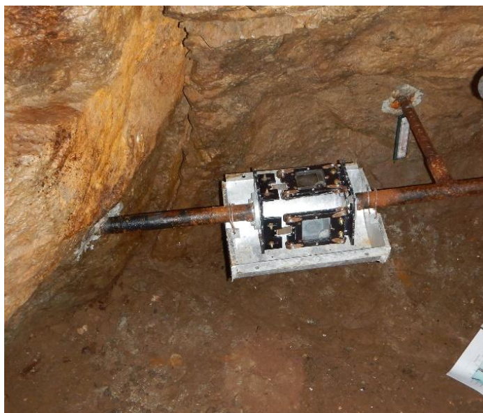
Obr. 39 Inštalácia dilatometra TM-71 v opustenej štôlni sv. Antona Paduánskeho na lokalite Vyhne
