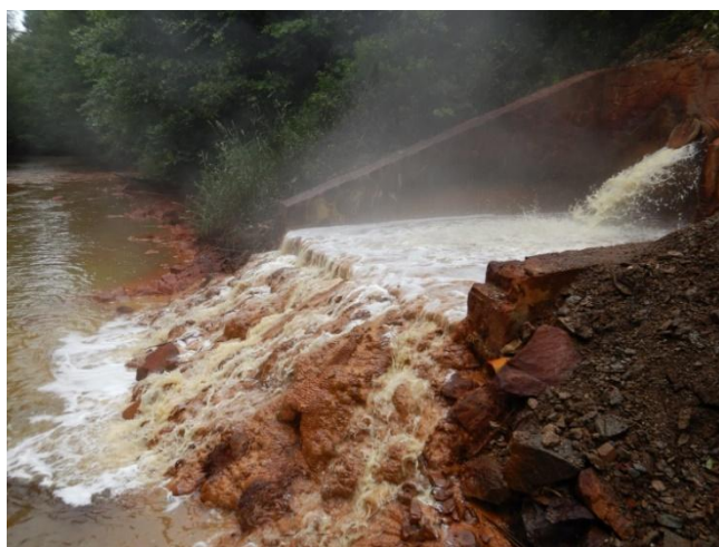
Obr. 4.7.2: Výpustný objekt banskej vody pod ústím štôlne Marta, na pravom brehu rieky Slaná. Z banskej vody sa intenzívne zráža železitý oker
