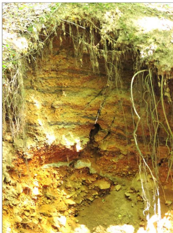
Obr. 4.4.5: Detail trhlín na V stene v smere na zával Z3.
