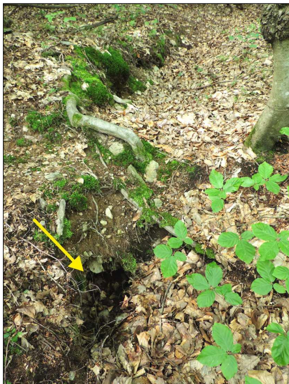
Obr. 4.7.9: Detail prepadnutia terénu – otvoru na trhline 12
