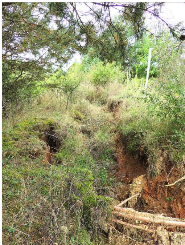
Obr. 4.12.6: Pohľad na trhlínu t1
