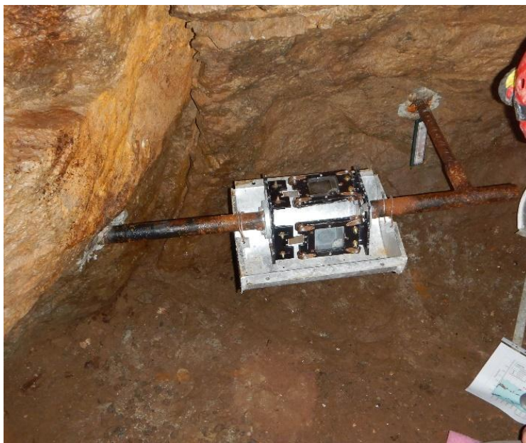
Obr. 38 Inštalácia dilatometra TM-71 v opustenej štôlni sv. Anton Paduánsky na lokalite Vyhne
