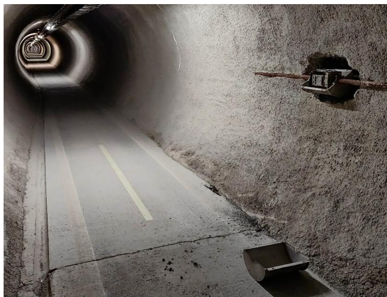
Obr. 34: Inštalácia dilatometra TM-71 v únikovej štôľni tunela Branisko
