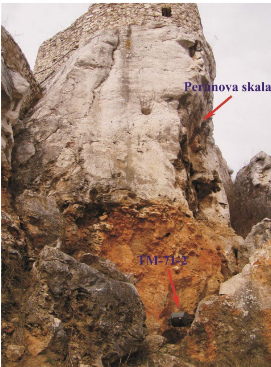
Obr. 10 Inštalácia dilatometra TM-71-2 v trhline pod Perúnovou skalou (vchod do Podhradskej jaskyne).
