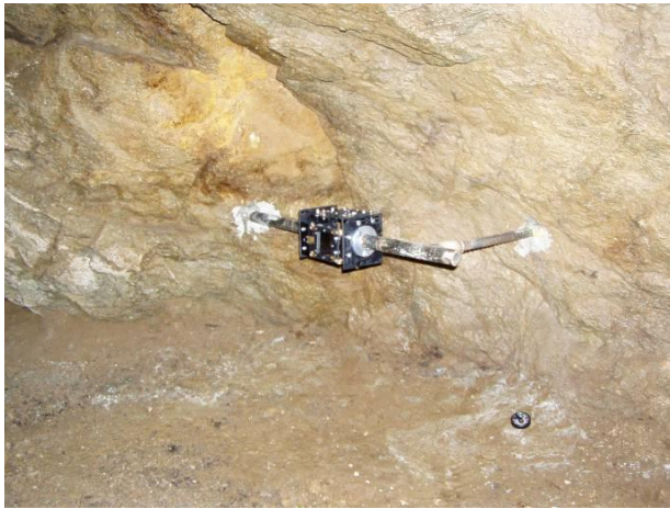
Obr. 37 Inštalácia dilatometra TM-71 v opustenej štólňi sv. Anton Paduánsky na lokalite Vyhne
