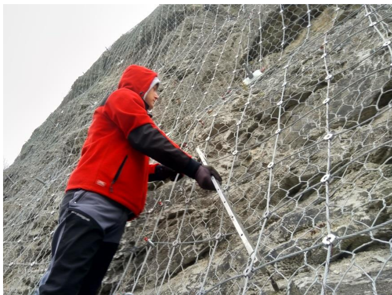
Obr. 4.20.2. Fotodokumentácia profilu Banská Bystrica-Jakub dňa 1. 12. 2020 (foto P. Ondrus).
