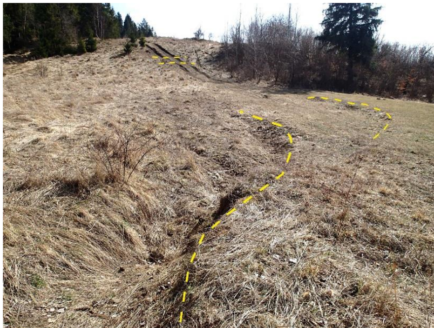
Obr. 31: Trhliny nad odlučnou plochou blokového zosuvu B8, v pozadí viditeľné trhliny naprieč poľnou cestou so spätným poklesom do svahu.
