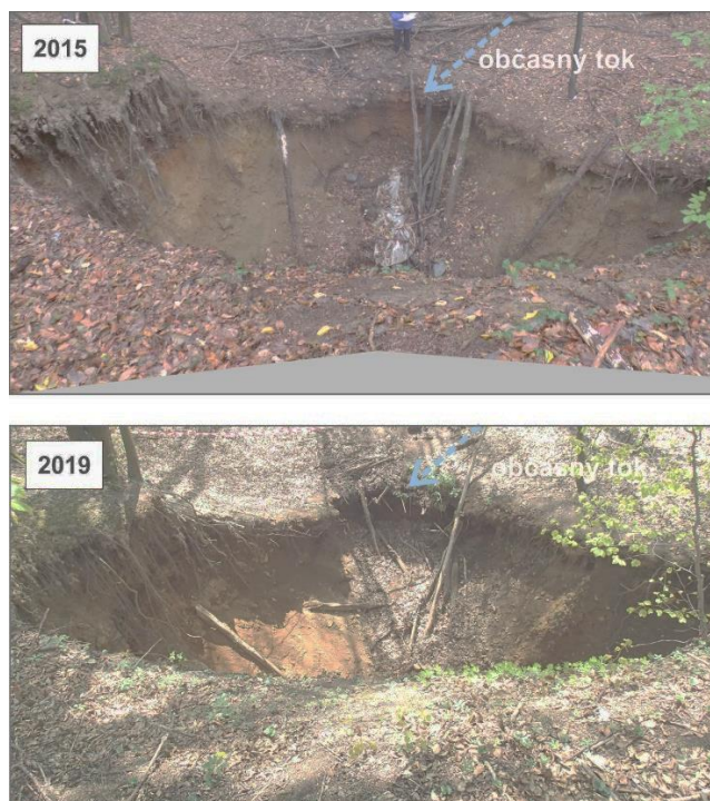
Obr. 14: Zával Z1 nad banskou chodbou štôlne Ryhová dokumentovaný v r. 2015 a 2019 (pohľad zo severu).
