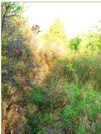
Obr. 65: Stena trhliny t5.
