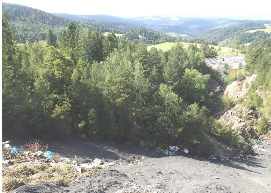
Obr. 34: Pohľad na svah násypu navážky popolčeka vo východnej časti závalového pásma Baniská.
