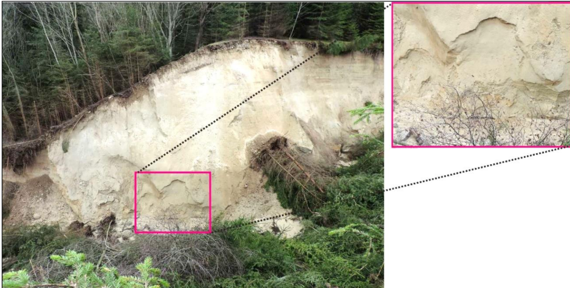
Obr. 7: Flotačný materiál odkaliska v mieste hrany plató odkaliska na bočnej severovýchodnej stene odľučnej oblasti svahovej deformácie (Mašlár a Mašlárová, 2019)
