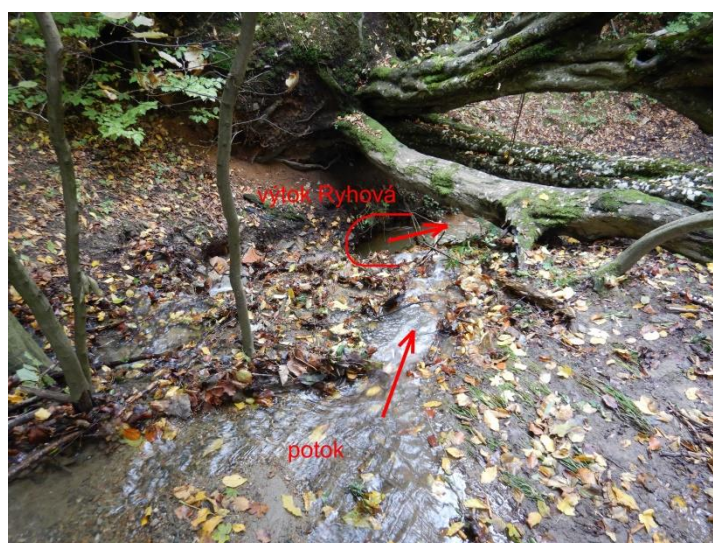
Obr. 20: Zavalené ústie štôlne Ryhová s výtokom banskej vody a tokom občasného potoka.
