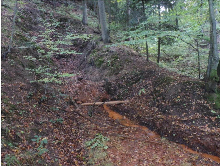
Obr. 2: Zavalené ústie štôlne 1. mája s výtokom banskej vody a zrážaním okru
