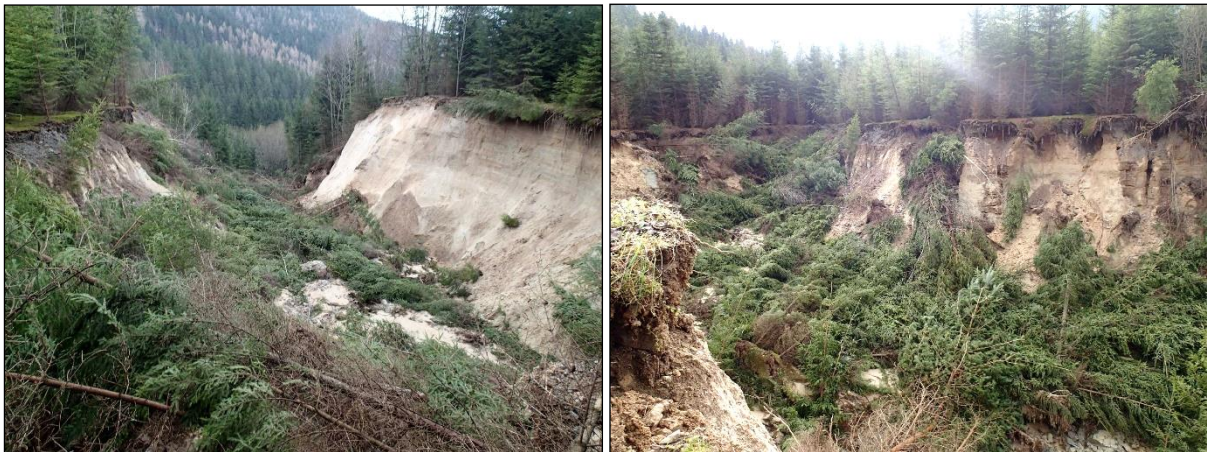
Obr. 8 (vľavo): Bočná severovýchodná stena odľučnej časti svahovej deformácie
