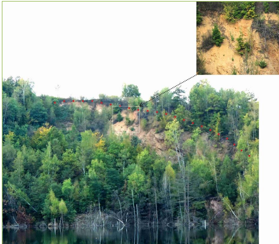
Obr. 63: Oblasť odlučnej hrany zosuvu v lome s detailom šmykovej plochy.
