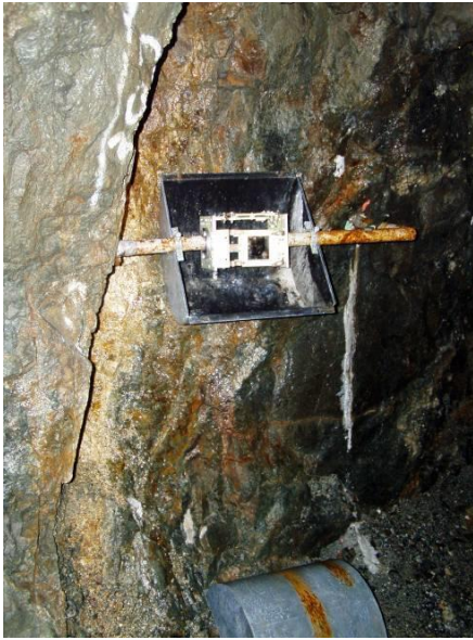
Obr. 30 Inštalácia dilatometra TM-71 v prieskumnej štôlni Izabela na lokalite Ipeľ
