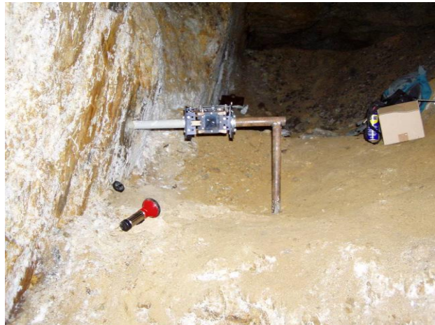
Obr. 31 Inštalácia dilatometra TM-71 v štôlni Všetech-svätých (stará) na lokalite Banská Hodruša (Hámre
