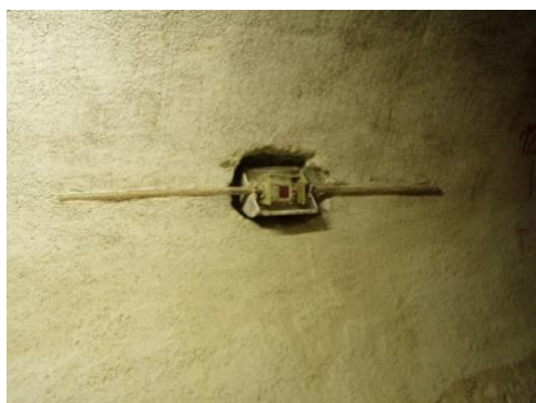
Obr. 28 Inštalácia dilatometra TM-71 v únikovej štôľni tunela Branisko
