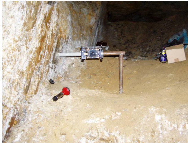
Obr. 31 Inštalácia dilatometra TM-71 v opustenej štólne Vŕsechsvätých (stará) na lokalite Banská Hodruša (Hámre)
