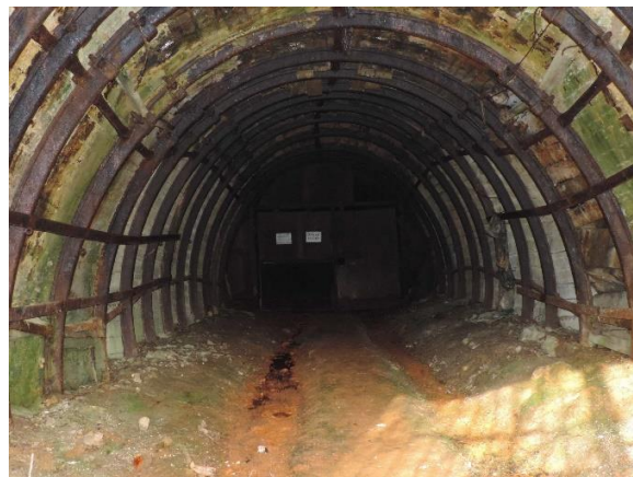
Obr. 41: Úvod banskej chodby úpadnice
