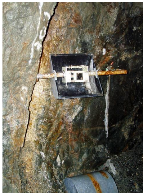
Obr. 18 Inštalácia dilatometra TM-71 v prieskumnej štôlni Izabela na lokalite Ipeľ
