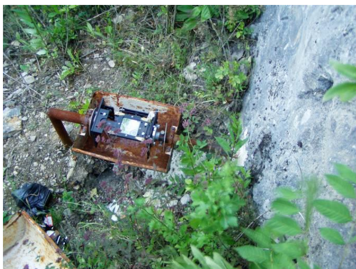
Obr. 21 Inštalácia dilatometra TM-71 na tektonickej poruche na lokalite Dobrá Voda
