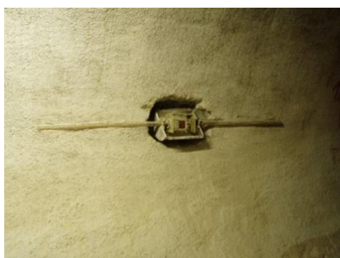
Obr. 16 Inštalácia dilatometra TM-71 v únikovej štólňi tunela Branisko
