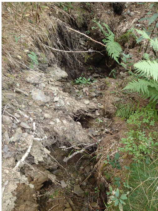
Obr. 33: Trhlina nad zosuvom ZH1
