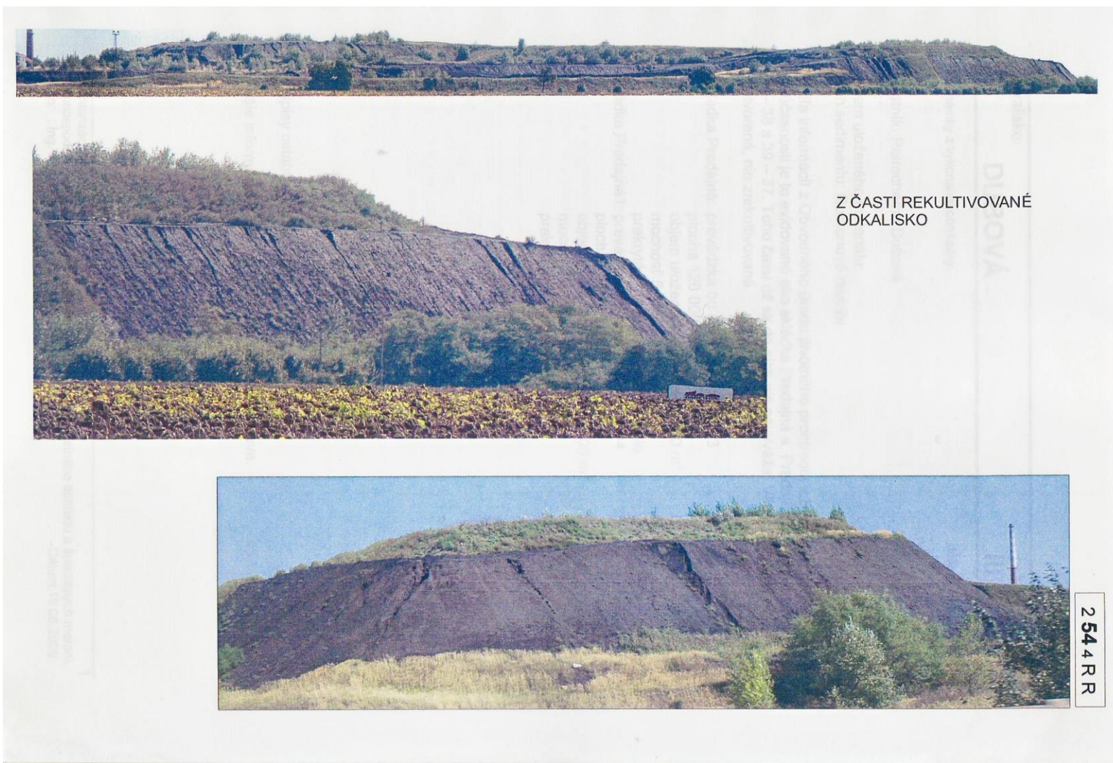
Obr.2.2 Fotodokumentácia (odkaliska) – skládky prevzatá z podkladu [4], r.10/2006
