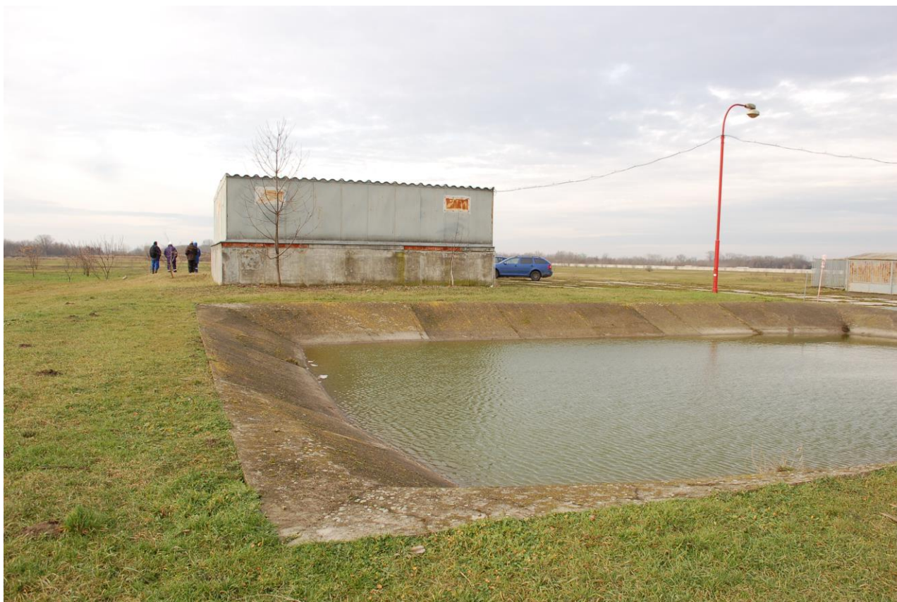
Obr.5.4 Akumulačná nádrž priesakových vôd
