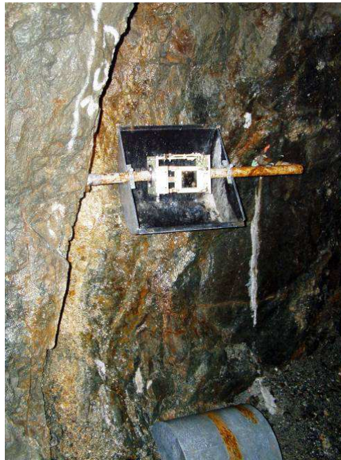
Obr. 19 Inštalácia dilatometra TM-71 v prieskumnej štôlni Izabela na lokalite Ipeľ
