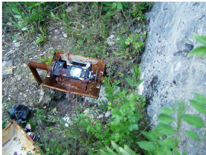
Obr. 22 Inštalácia dilatometra TM-71 na tektonickej poruche na lokalite Dobrá Voda
