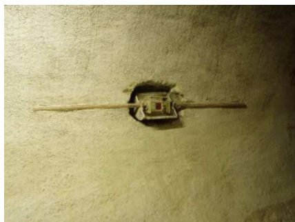
Obr. 17 Inštalácia dilatometra TM-71 v únikovej štôlni tunela Branisko
