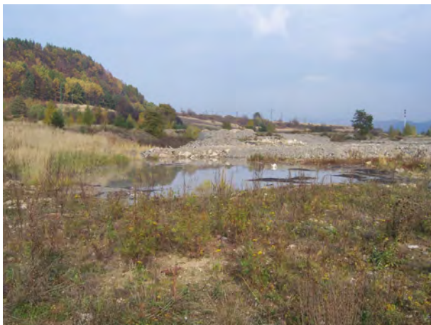
Obr. 4.45.3. Ukladanie nevhodných materiálov na západnom okraji násypu (neďaleko od vtokového objektu Nepomenovaného potoka) a vytváranie „jazier“ neznámych viskózných látok (foto Z. Nagy, 2008)
