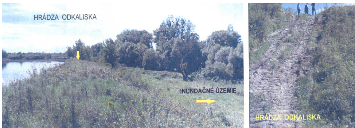
Obr.5.4 Hrádzový systém odkaliska (prevzaté z [2])
