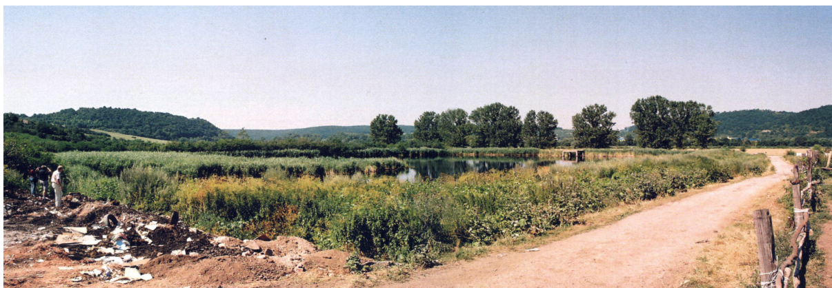
Obr.6.3 Pohľad na nádrže odkaliska v r.2006
