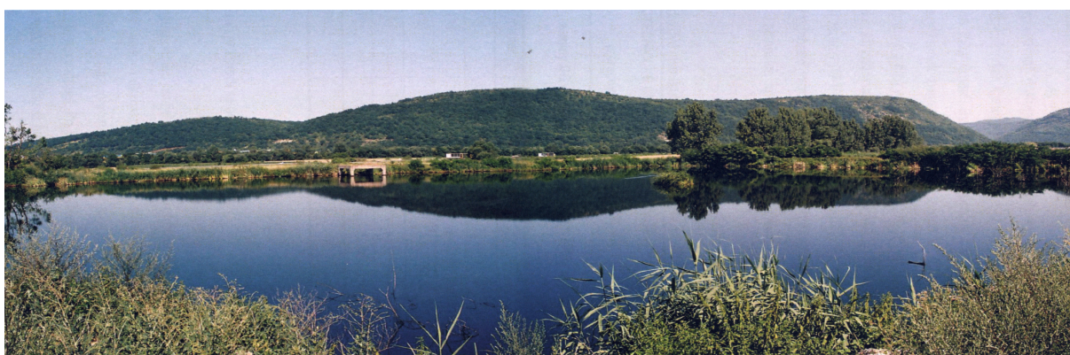
Obr.6.4 Pohľad na nádrže odkaliska v r.2006
