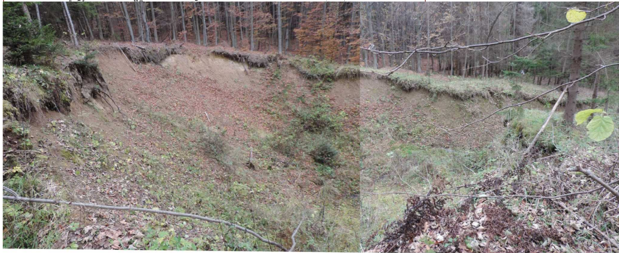
Obr. 37 Severná stena hlavného závalu na Novej štôlni.
