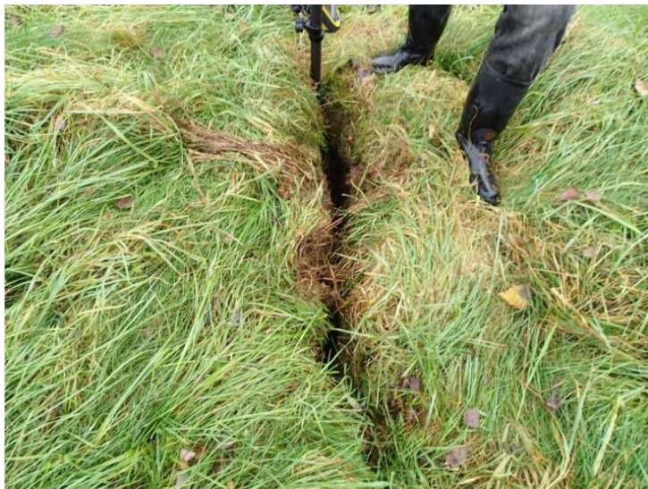
Obr. 18 : Otvorená ťahová trhlina na východnom okraji závalového pásma.
