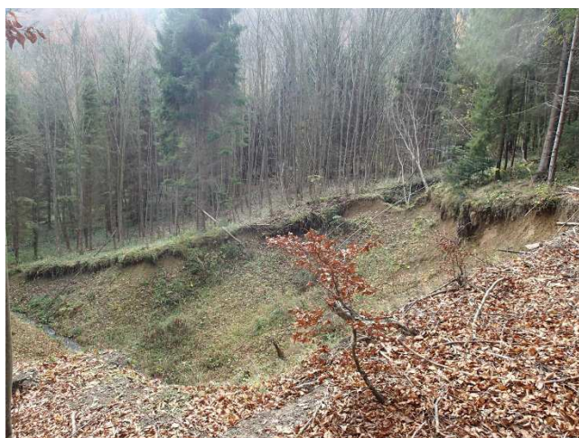
Obr. 38 Južná stena hlavného závalu na Novej štôlni
