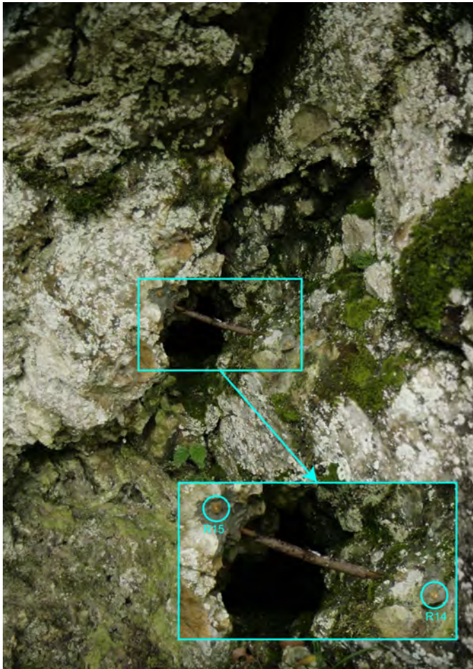
Obr. 1.184. Umiestnenie pozorovacích bodov R14 a R15 (Stanovište 2) pre merania dilatometrom Somet na lokalite Pod večným dažďom (Slovenský raj)
