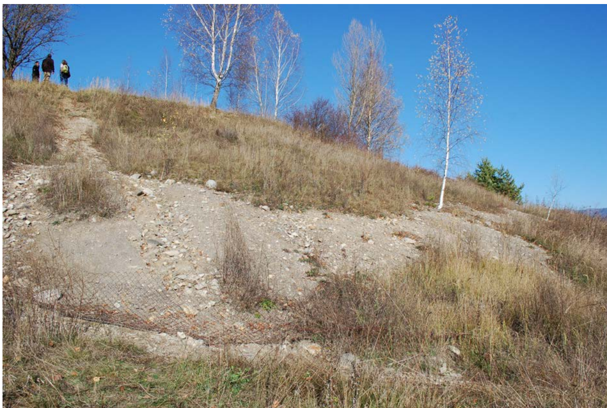
Obr. 2.5 Hrádzový systém skládky - odkaliska Predajná I, október 2013 (KGTE)
