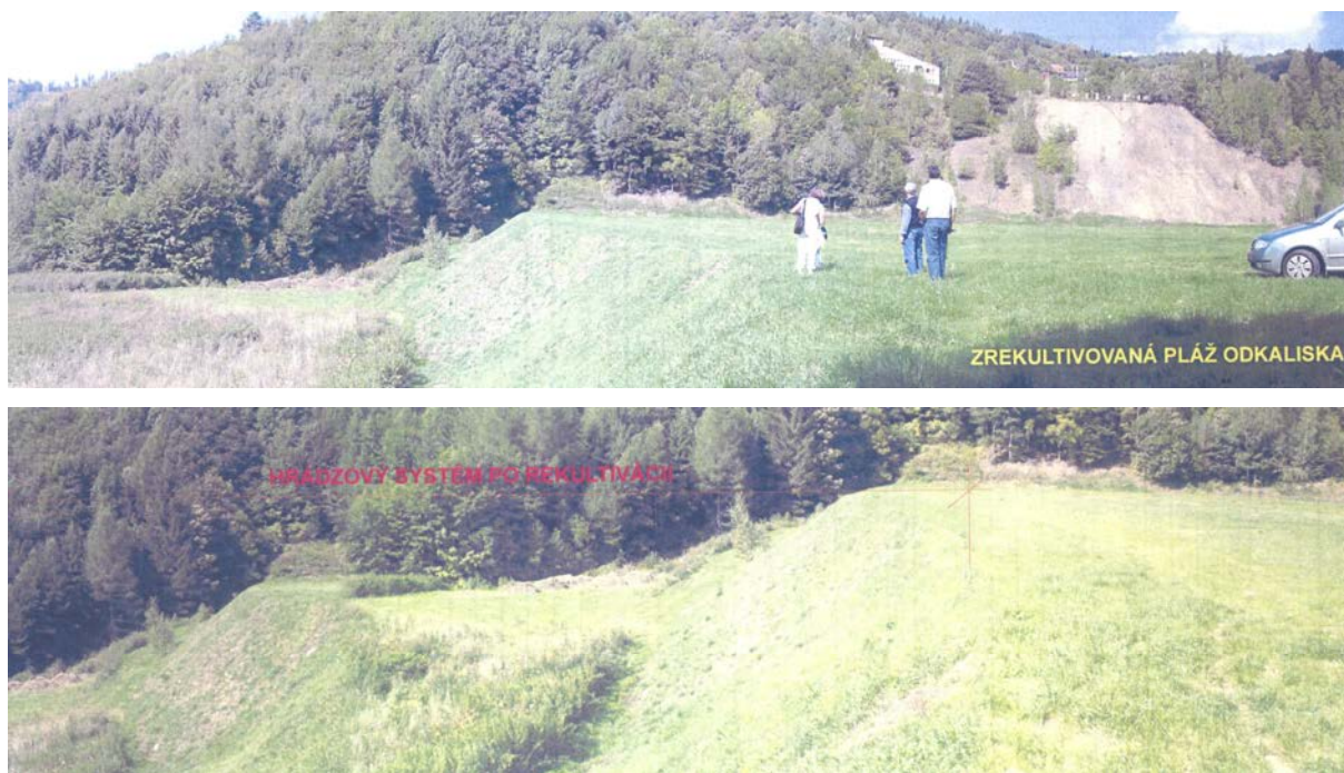
Obr. 5.2 Stav odkaliska v r. 2006 (prevzaté z [2])
