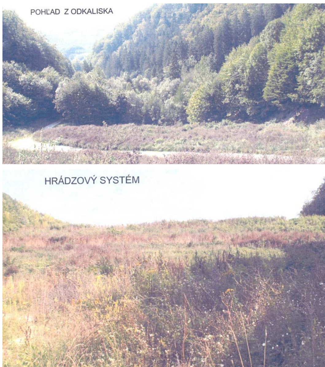
Obr. 6.2 Stav odkaliska v r. 2006 (prevzaté z [2])
