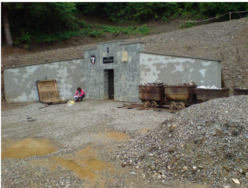
Obr. 18: Rekonštruované ústie štôľne Vŕechsvätých pri Poráči
