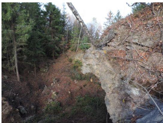
Obr. 9: Západná časť závalu objektu [1]
