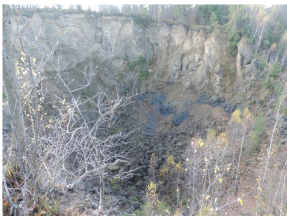
Obr. 13: Charakter závalu objektu [2] v jeho východnej časti
