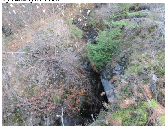
Obr. 14: Puklina na okraji objektu [2] v jeho západnej časti
