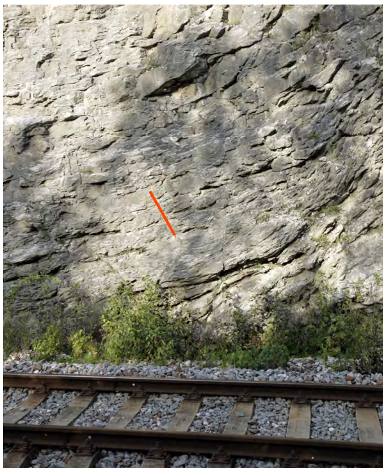
Obr. 1.167. Umiestnenie stanoviska na meranie mikromorfologických zmien povrchu odkrytého zárezu železnice pri obci Jakub. Červenou líniou je zvýraznené stanovisko umiestnenia meradla morfológických zmien
