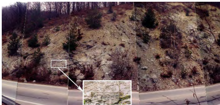
Obr. 1.173. Skalná stena odrezu cesty na lokalite Lipovník (s detailom umiestnenia meradla mikromorfologických zmien – foto Ľ. Petro, 2006)
