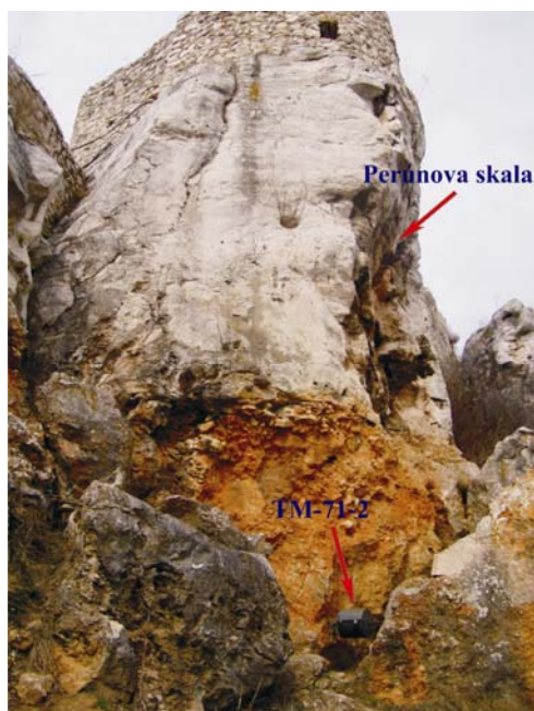
Obr. 17: Inštalácia dilatometra TM-71-2 v trhline pod Perúnovou skalou (vchod do Podhradskej jaskyne).
