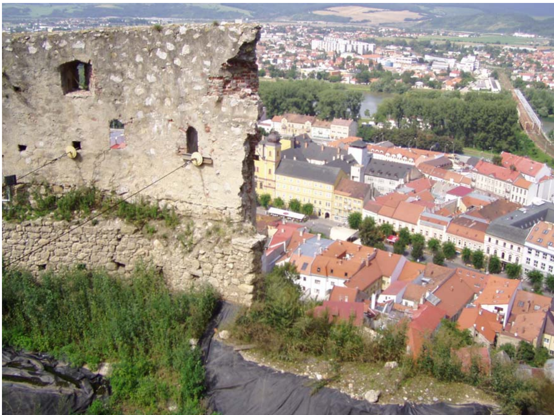
Obr. 8: Zrútenie časti múra vonkajšieho opevnenia na Trenčianskom hrade (Foto: E. Petro)
