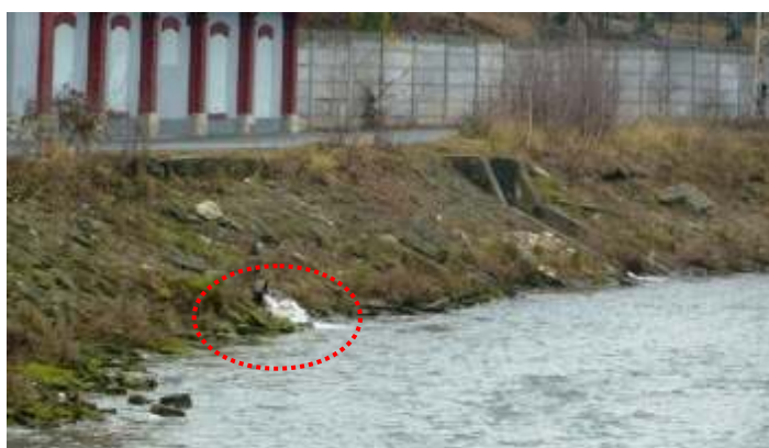
Obr. 2.7.2.: Výpust vody z areálu podniku v časti Kovohuty.
