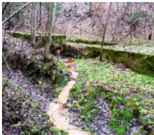
Obr. 2.13.2.: Výtok vody z drenáže pod odkaliskom
