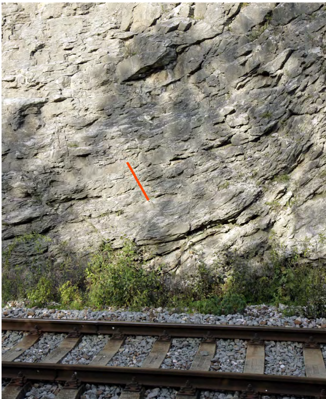
Obr. 1.126 Umiestnenie stanoviska na meranie mikromorfologických zmien povrchu odkrytého zárezu železnice pri obci Jakub. Červenou líniou je zvýraznené stanovisko umiestnenia meradla morfologických zmien
