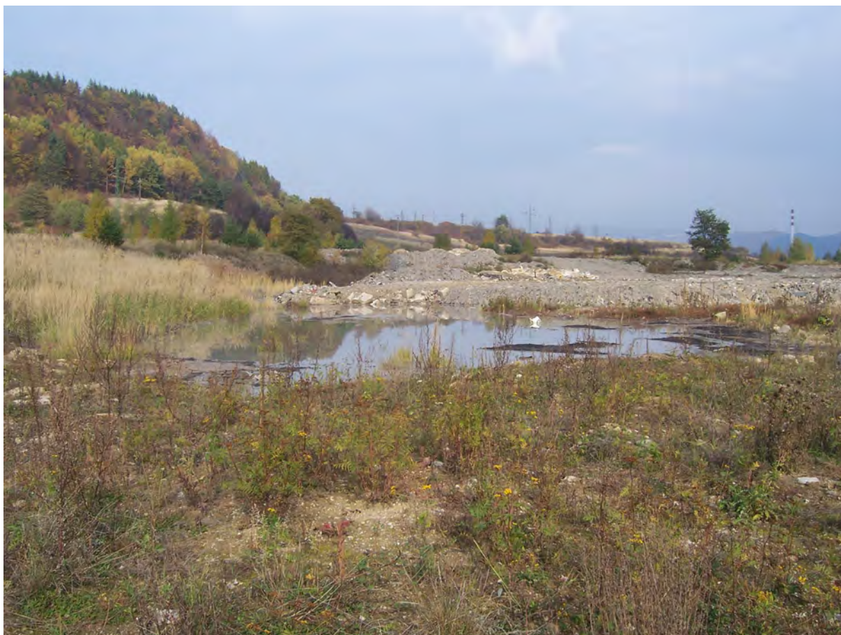
Obr. 1.136 Ukladanie nevhodných materiálov na západnom okraji násypu (neďaleko od vtokového objektu Nepomenovaného potoka) a vytváranie „jazier“ neznámych viskózných látok (foto Z. Nagy, 2008)
