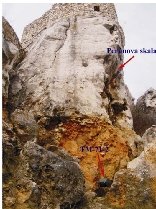
Obr. 14 Inštalácia dilatometra TM-71-2 v trhline pod Perúnovou skalou (vchod do Podhradskej jaskyne).
