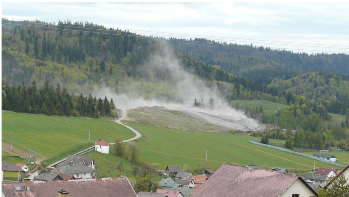
Obr. 13 Zvýšená prašnosť pri zavážaní závalového pásma elektrárenským popolčekom; v popredí domy obce Poráč. Foto: P. Bajtoš 7.5.2011
