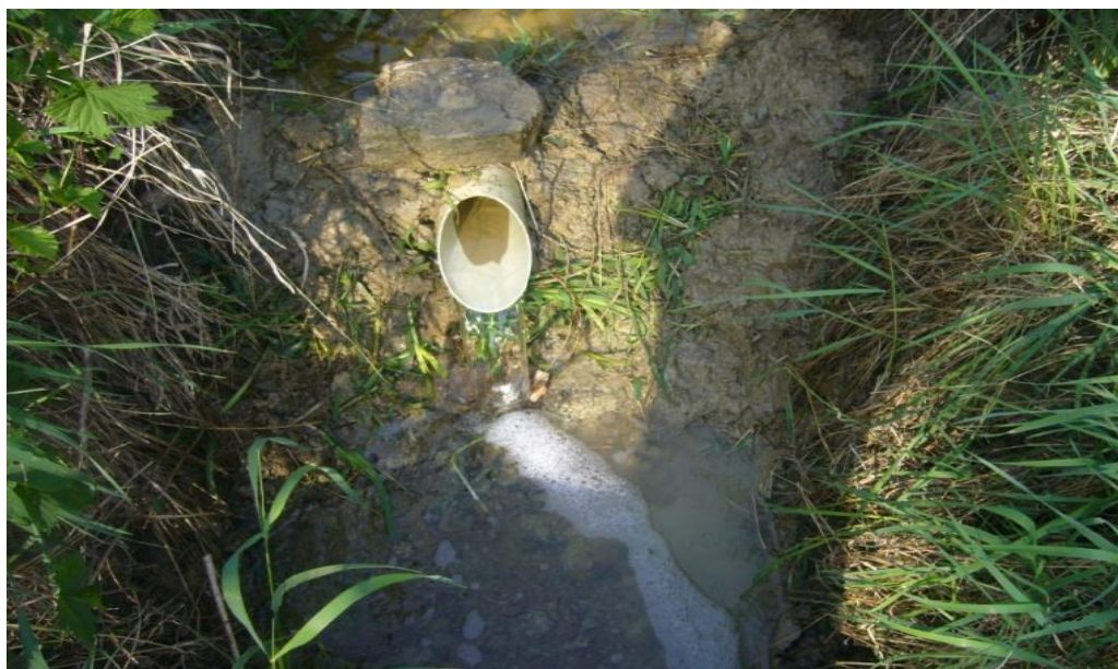
Obr. 3.1.2.2. Výtok z čela skládky. Meranie prietoku v rigole.
