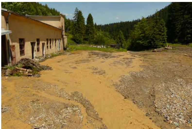
Obr. 12: Nánosy sedimentu erodované z lesnej cesty banskou vodou z kráteru nad Novou štôľňou. Foto P. Bajtoš, 6.6.2010.
