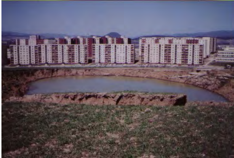
Obr. 16: Prepadlisko v lúhovacom poli ložiska Prešov - Solivar (apríl 1988).
