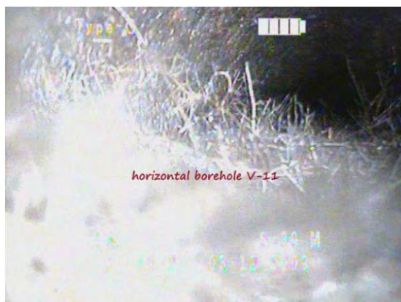
Obr. 2.1.49: Zanesené horizontálne odvodňovacie vrty V-5 a V-11 v oblasti ústia
