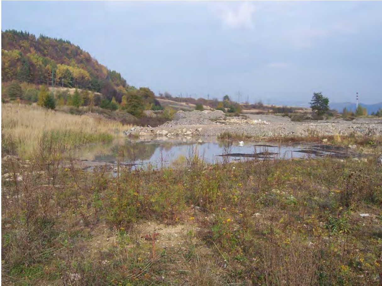
Obr. 2.1.99: Ukladanie nevhodných materiálov na západnom okraji násypu (neďaleko od vtokového objektu Nepomenovaného potoka) a vytváranie „jazier“ neznámych viskózných látok (foto Z. Nagy, 2008)
