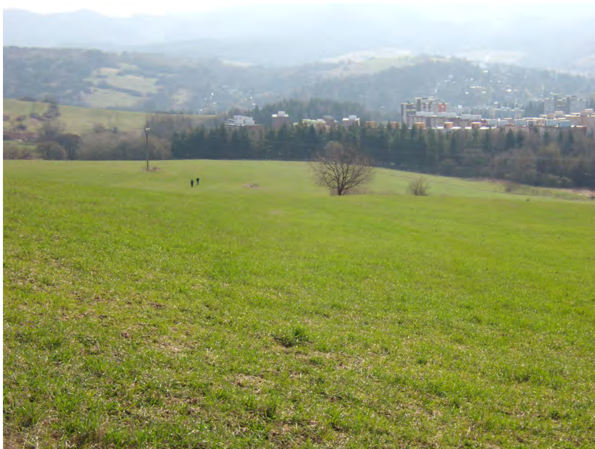
Obr. 2.1.16: Pohľad od odlučnej oblasti na zosuvný svah nad Morovnianským sídliskom (foto P. Wagner, 2009)
