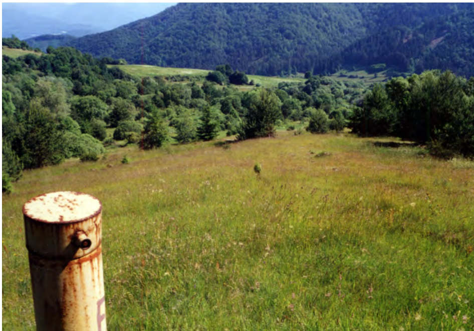
Obr. 2.1.42: Pohľad od pevného bodu F-4 na časť transportačnej oblasti zosuvu v Ľubietovej (foto P. Wagner, 2002)
