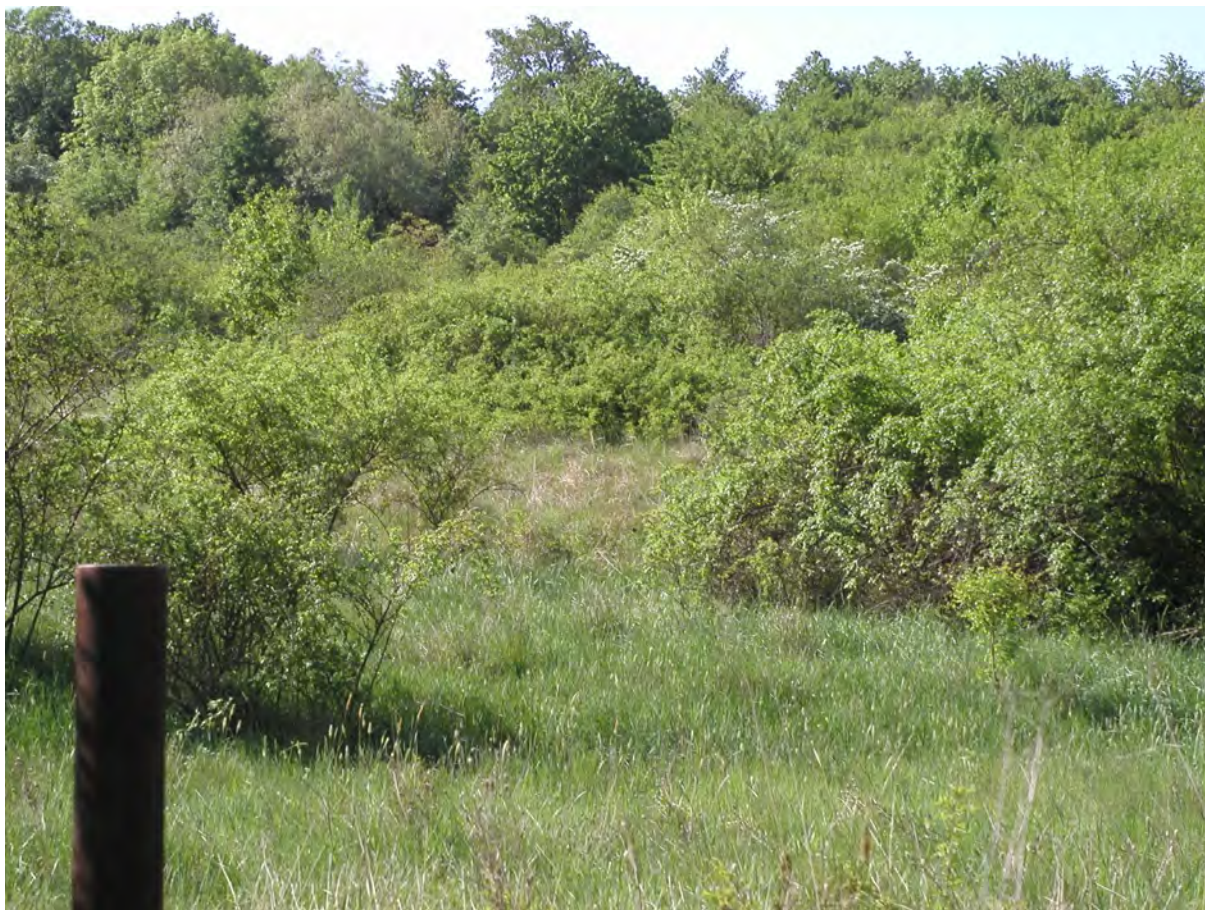
Obr. 2.1.95: Pohľad na časť zosuvného územia nad obcou Vištuk (foto P. Wagner, 2006)
