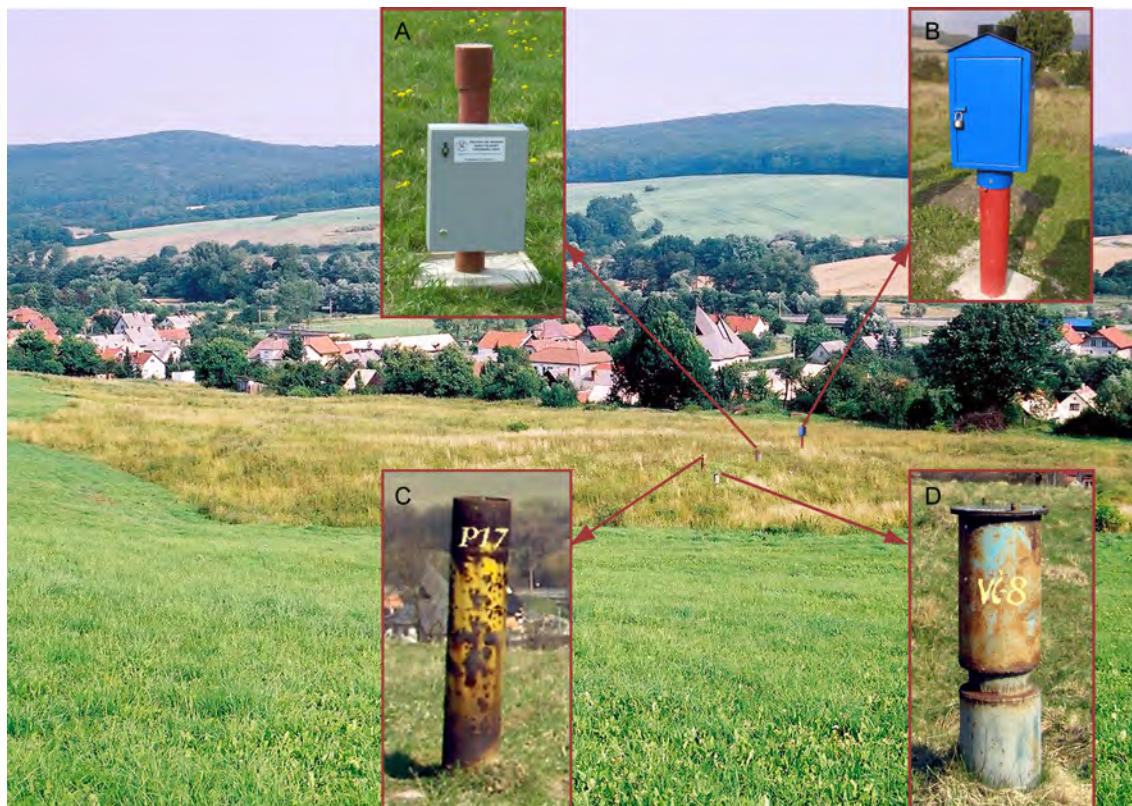
Obr. 2.1.4: Zosuv nad obcou Veľká Čausa – pohľad od odlučnej oblasti na teleso zosuvu s niektorými monitorovacími objektmi. A – kontinuálny inklinometer umiestnený vo vrte KI-1, B – automatický hladinomer so systémom včasného varovania umiestnený vo vrte AH-1, C – geodetický bod P17, D – automatický hladinomer umiestnený v inklinometrickom vrte VČ-8 (foto P. Ondrejka, 2009)
