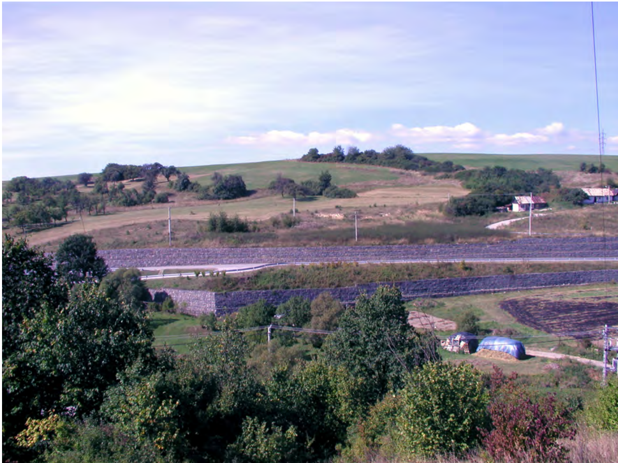
Obr. 2.1.35: Pohľad na sanovaný zosuv pri obci Dolná Mičiná (foto P. Wagner, 2007)
