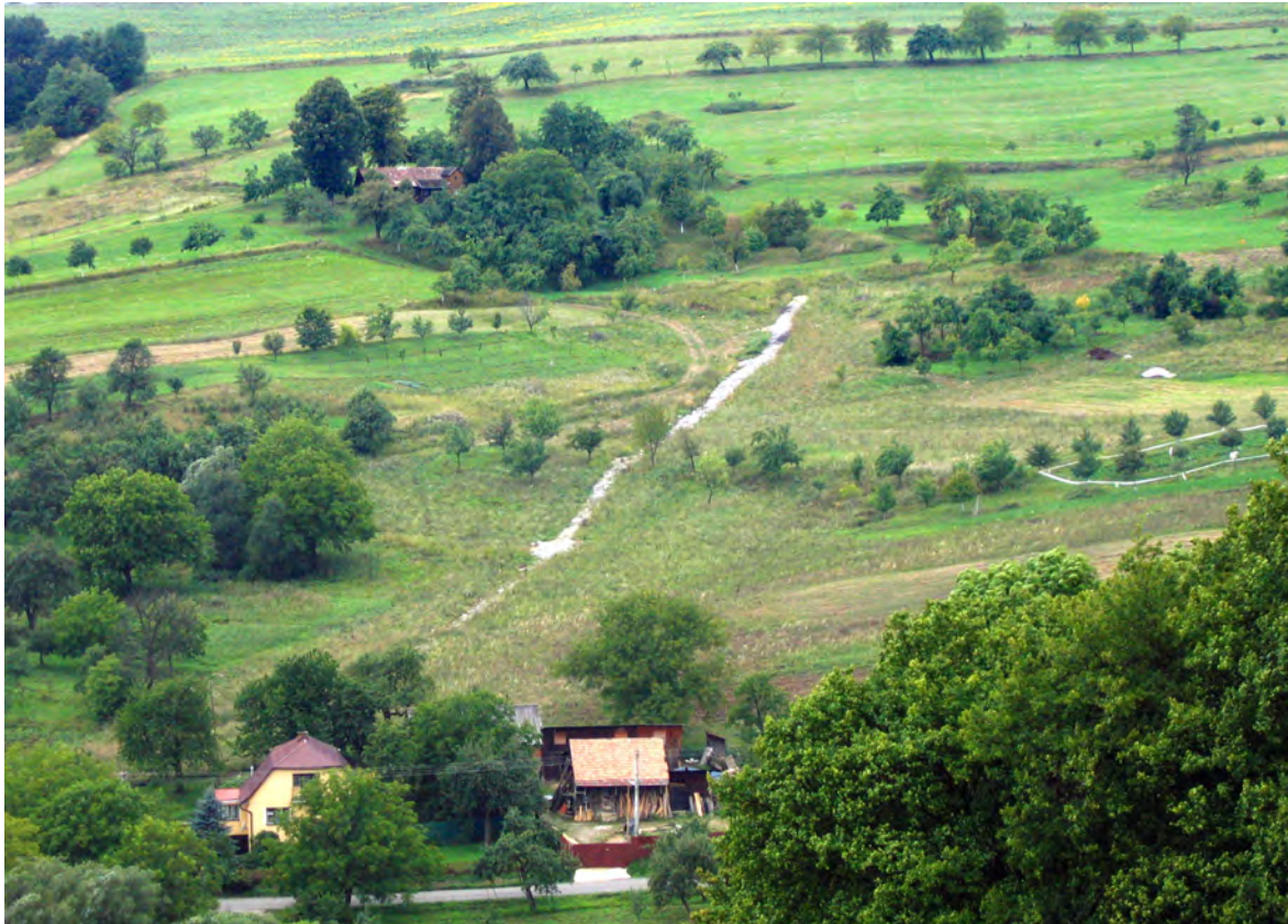
Obr. 2.1.87: Pohľad na sanovaný zosuvný svah na SZ okraji obce Kvašov. V centrálnej časti je línia hlavného odvodňovacieho drénu, zasypaného kamennou drvinou (foto P. Ondrejka, 2007)
