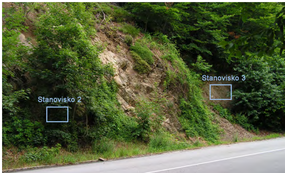
Obr. 2.1.154: Situovanie stanovísk 2 a 3 na lokalite Pezinská Baba na meranie mikromorfologických zmien povrchu horniny na svahu odrezu cesty (foto P. Ondrejka, 2007)
