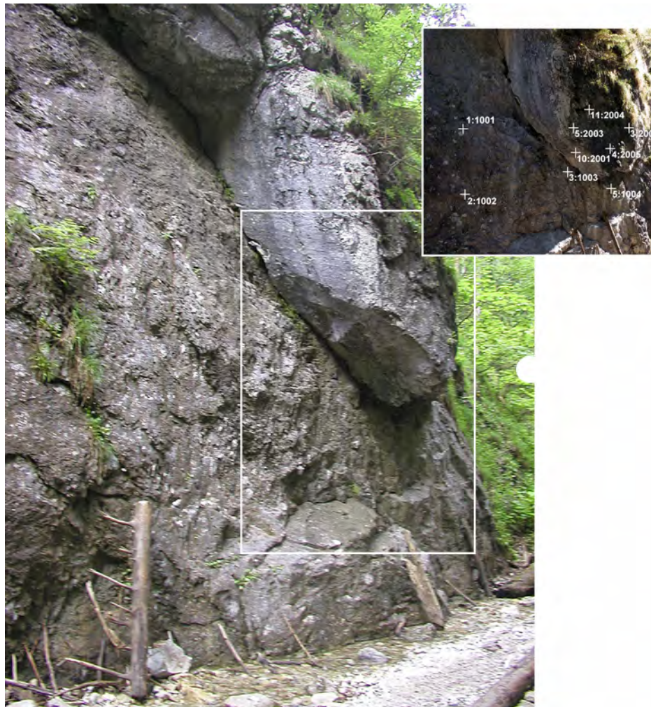
Obr. 2.1.171: Potenciálne nestabilný skalný blok nad turistickým chodníkom v doline Suchá Belá. V detaile je rozmiestnenie vzťažných a pozorovaných bodov pre fotogrametrické snímokovanie (foto P. Bartoš, 2006)
