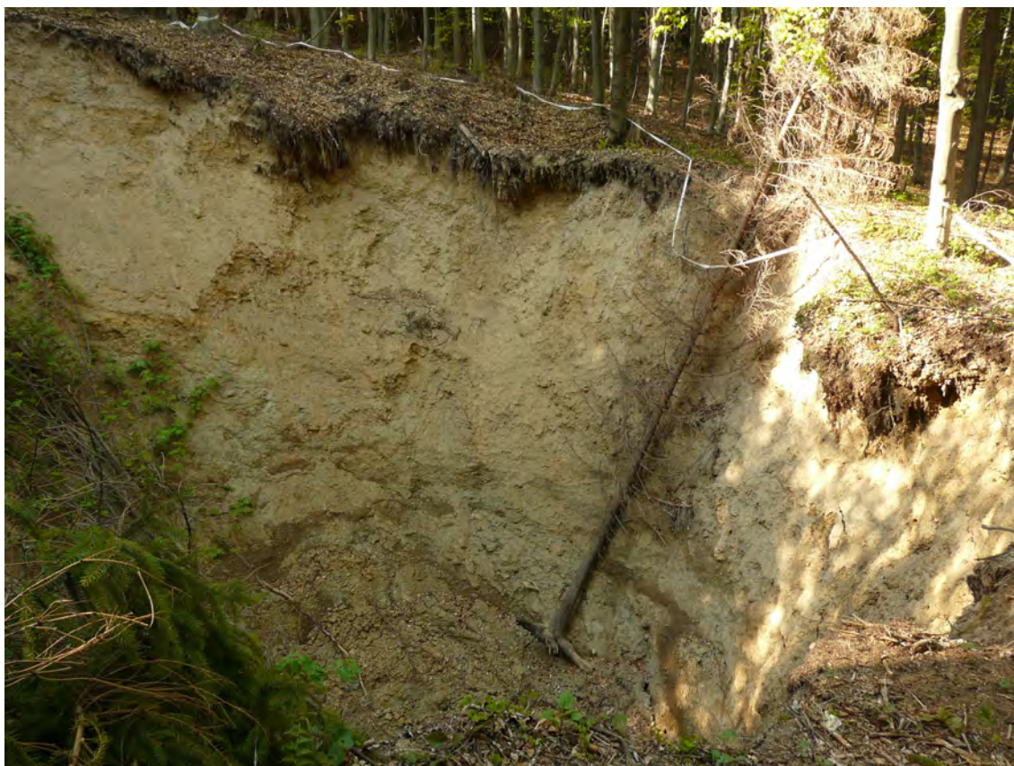
Obr. 108: Teplá ka nad Hornádom o následky prevalu banskej vody z Novej Ťolne. Kráterový zával nad Novou Ťolňou o pohľad z JV. Priemer krátera 15 m, hĺbka 8-10 m. Foto: P. Bajto, 3.5.2009.
