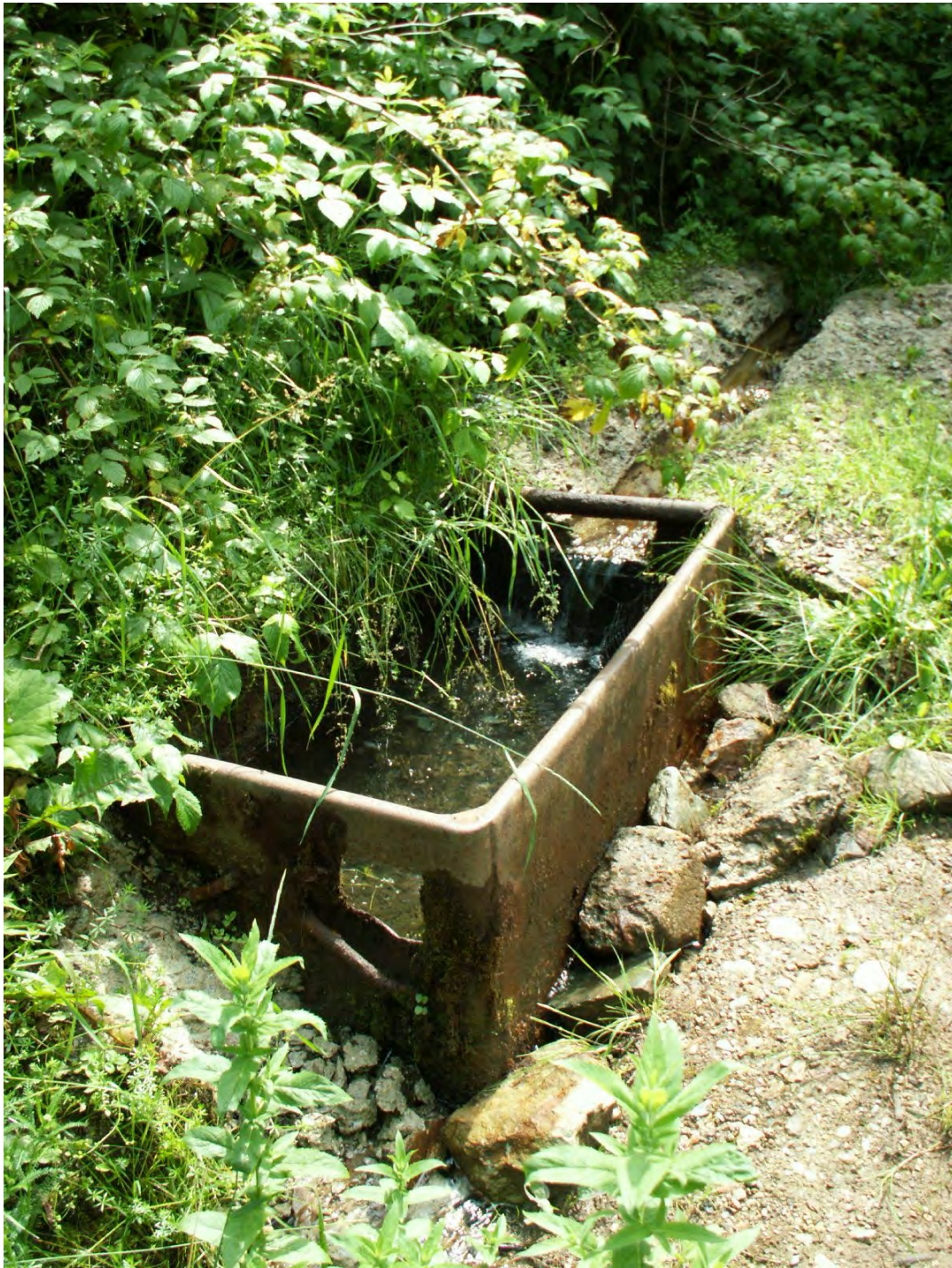
Obr. 45: Lokalita Slovinky. Priesak spod starého odkaliska .2 zvedený rigolom do banského vozíka Foto: P. Bajto-, 26.6.2008
