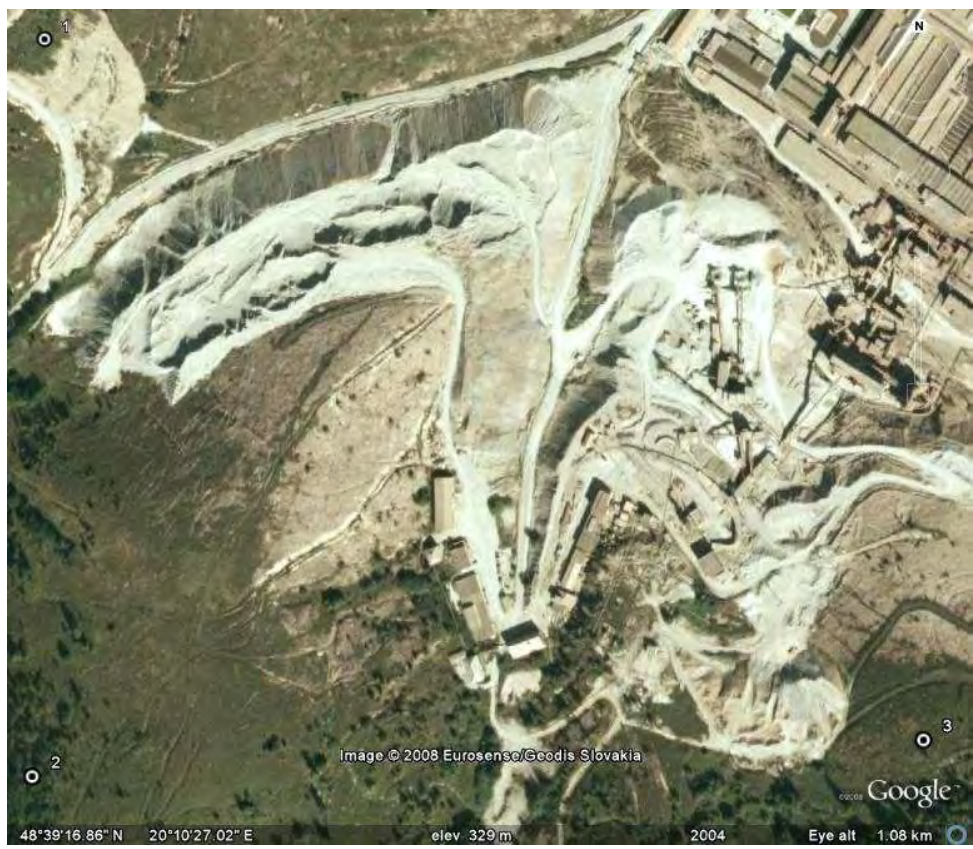
Obr.7: Lokalita Lubeník. Haldy v areáli závodu Slovmag. Zdroj: Google Earth, satelitná snímka z roku 2004.
