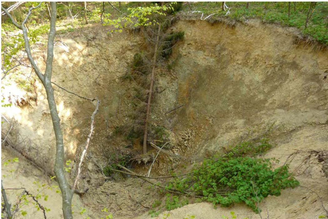
Obr. 110: Teplá ka nad Hornádom o následky prievalu banskej vody z Novej Ťolne. Kráterovitý zával nad Novou Ťolnou o pohľad zo Z. Priemer krátera 15 m, hĺbka 8-10 m. Foto: P. Bajto, 3.5.2009.
