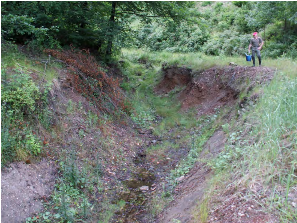
Obr. 43: Lokalita Slovinky. Horný okraj odvod ovacieho rigolu (betónové panely) odkaliska Slovinky je v úrovni kde stojí J. Blahut. Vy—ie je neizolované koryto potoka zarezané v materiáli odkaliska. Foto: P. Bajto-, 26.6.2008
