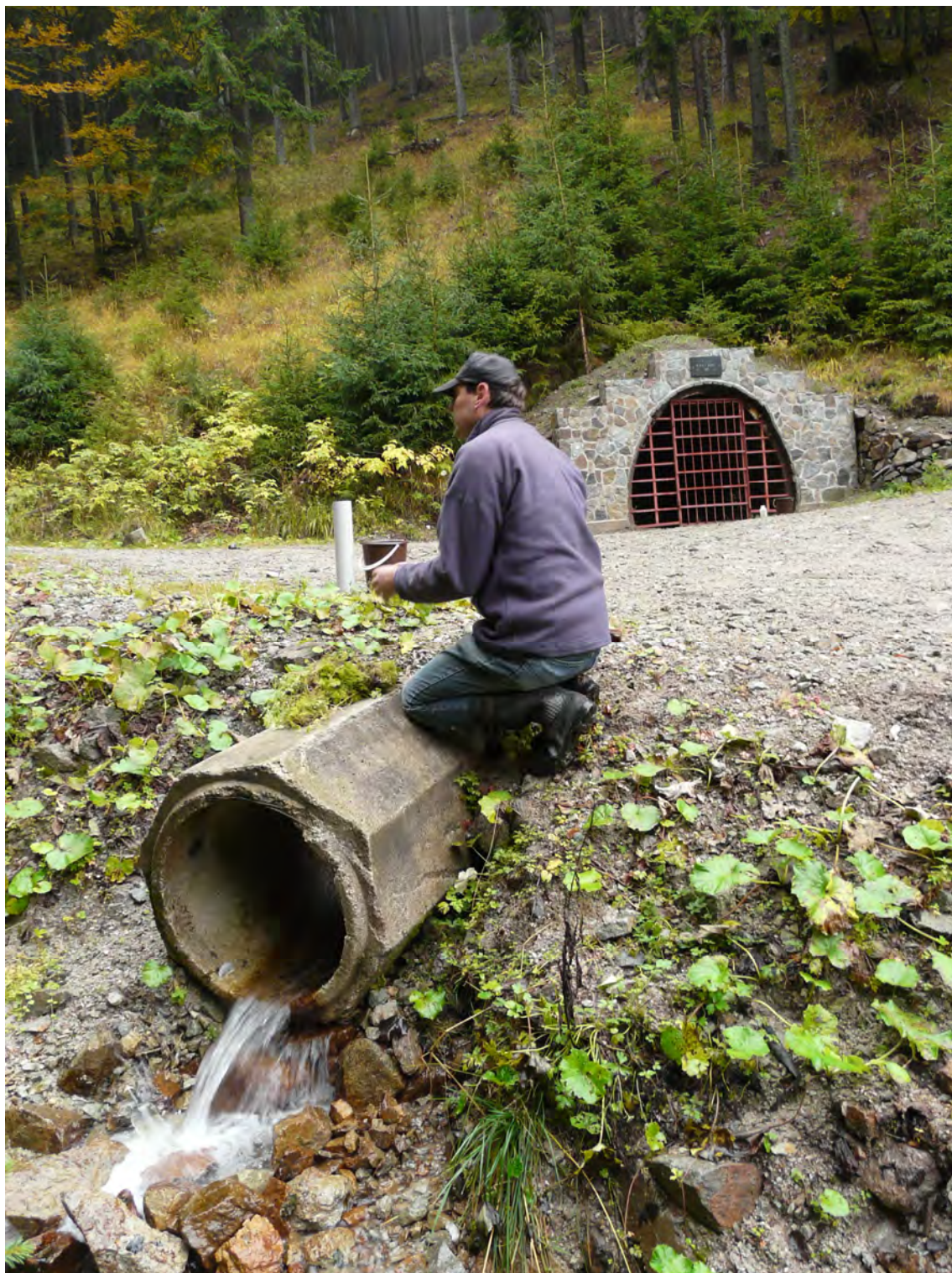
Obr. 91: Lokalita Dúbrava. Ústie a portál ťolne Rakytová, pred ťou odpadové potrubie s výtokom banskej vody do potoka. Foto: P. Bajtoť, 3.10.2008.
