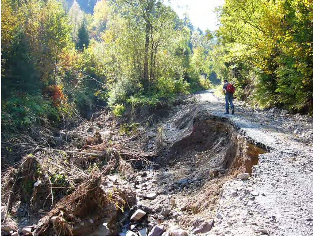
Obr. 104: Teplá nad Hornádom o následky prievalu banskej vody z Novej Hôrky. Erózia pôvodného koryta potoka pod Hôrkou a deštrukcia vozovky. Foto: P. Baláž, 2.10.2008.
