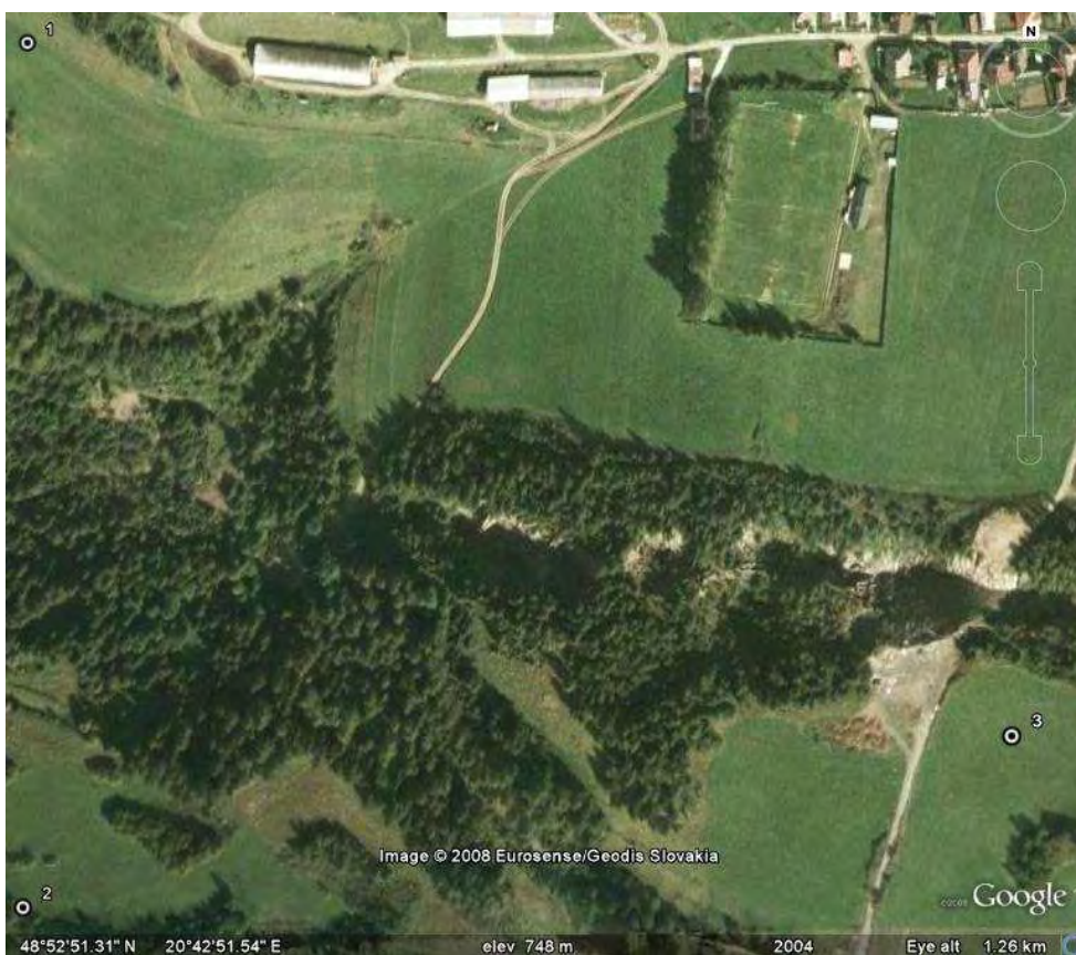
Obr. 20: Z časť závalového pásma Rudňany s prepadnutou starou cestou Rudňany – Poráč, JV od futbalového ihriska obce Poráč. Zdroj: Google Earth, satelitná snímka z roku 2004.
