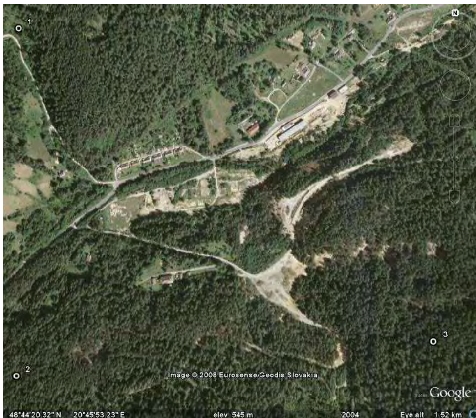
Obr. 27: Lokalita Smolník. Areál bývalého ťažobného závodu ŽB s haldami a pásmom závalov (doprava od svetlej plochy trojuholníkového tvaru). Zdroj: Google Earth, satelitná snímka z roku 2004.
