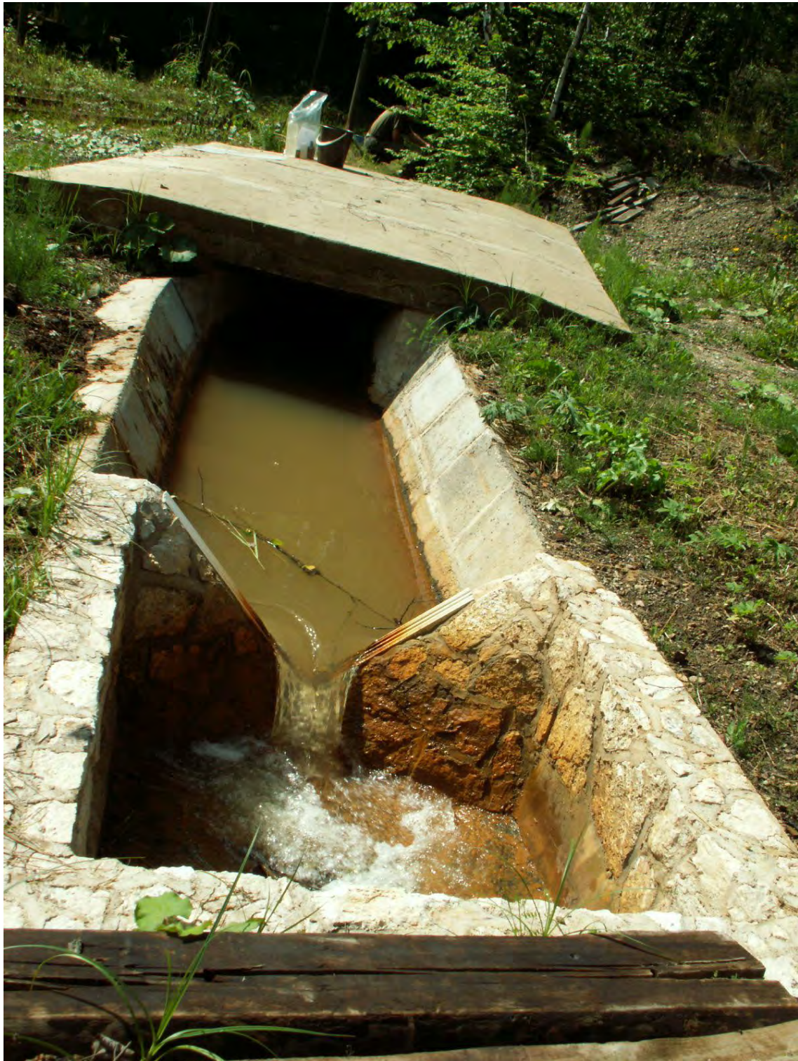
Obr. 41: Lokalita Slovinky. Merný objekt na výtokú banskej vody zo -tölne Alfbeta v Slovinkách. Foto: P. Bajto-, 26.6.2008
