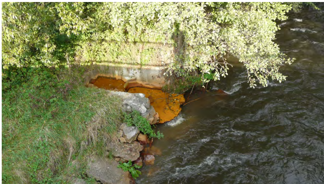
Obr. 77: Lokalita Roľava. Výus odpadového potrubia z Dopravného prekopy s merným prahom do rieky Slaná, pohľad z mosta. Foto P. Bajtoš, 18.9.2008.
