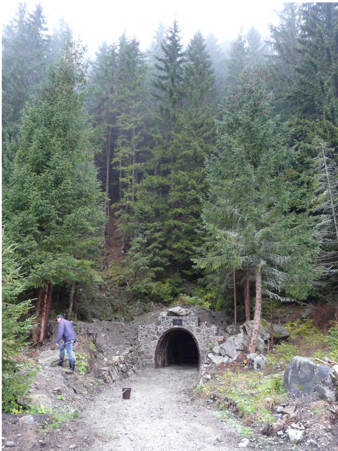
Obr. 88: Lokalita Dúbrava. Ústie a portál -tôlne Samuel. Foto: P. Bajto-, 3.10.2008.
