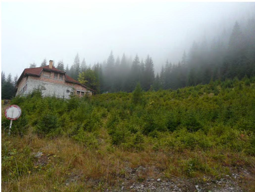
Obr. 86: Lokalita Dúbrava. Rekultivovaná halda pod ťôľou Samuel. Výtok banskej vody z tejto ťôľne je vyvedený potrubím na horný okraj haldy kde vo ne vyteká na jej svah a vsakuje do . Foto: P. Bajto-, 3.10.2008.
