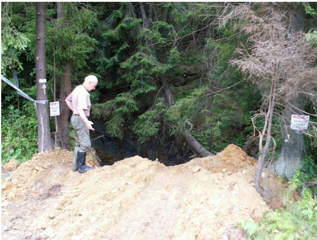
Obr. 63: Lokalita Smolník. Nový zával pri ceste nad odkaliskom likvidovaný zasypávaním. Foto: P. Bajto-, 30.6.2008.
