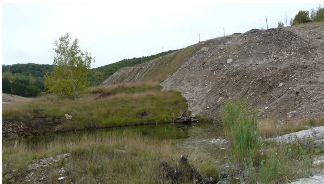
Obr. 15: Lokalita Lubeník. Priesak zo skládky inertného odpadu do šjazierko. 18.9.2008 Foto © P. Bajtoš, 18.9.2008.
