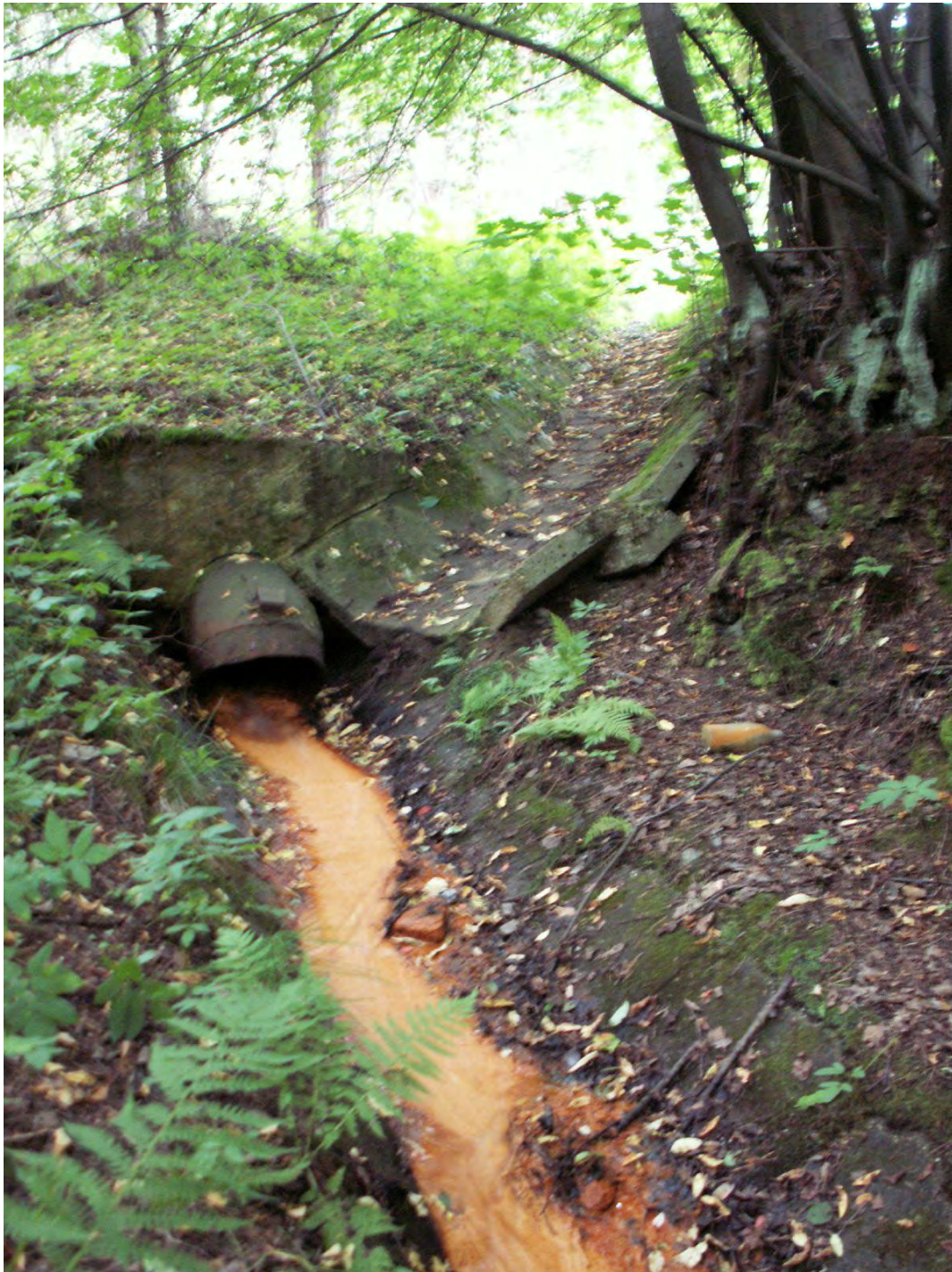
Obr. 71: Lokalita Smolník. Drenáfl z odkaliska Smolnícka Huta ó horný výpust. Foto: P. Bajto-, 30.6.2008.
