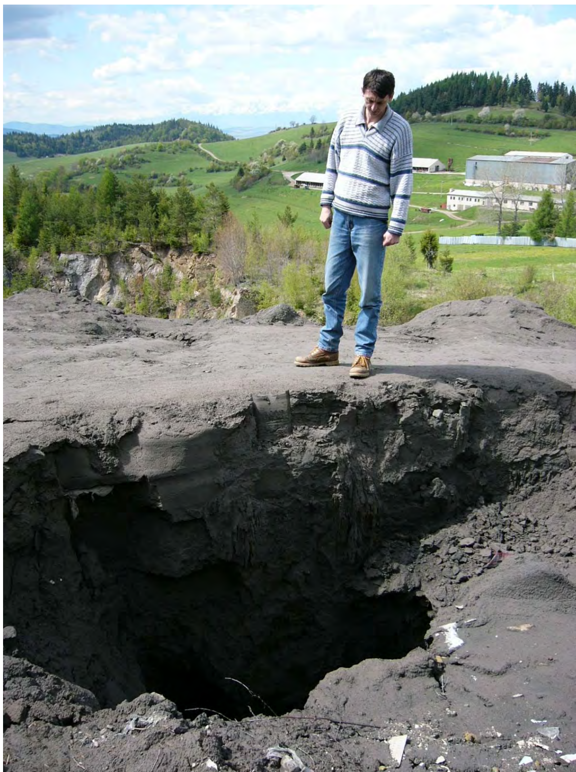
Obr. 38: Lokalita Rud aný. Závalové pásmo fiily Drofkdiak pri Porá i zaváflané elektrárenským popol ekom. Foto: P. Baláfi, 12.5.2005.
