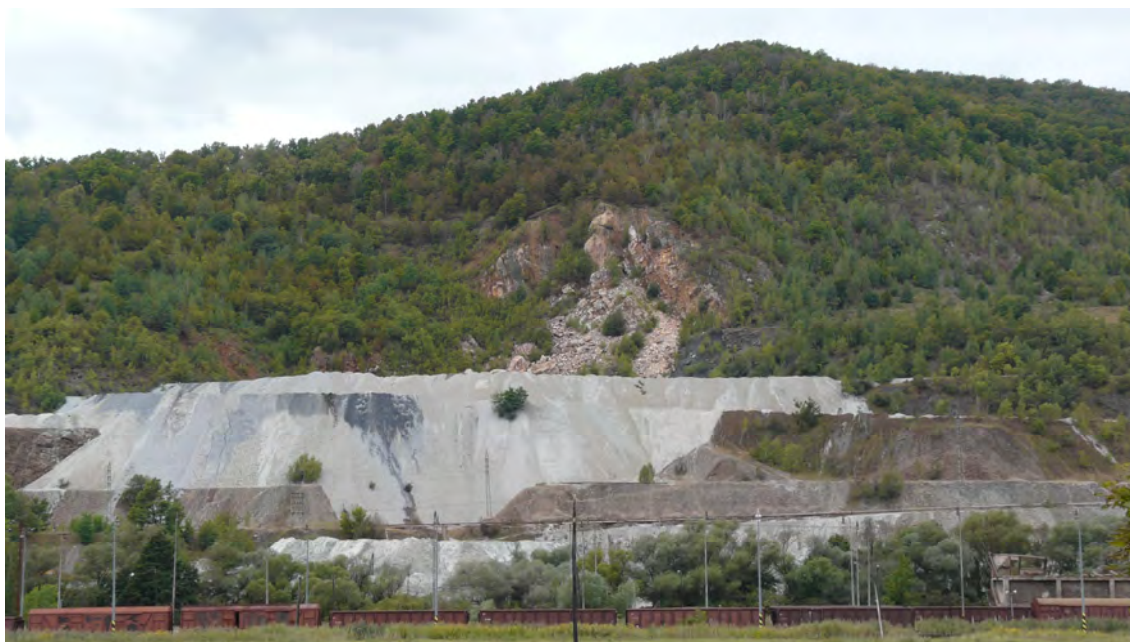
Obr. 31: Lokalita Lubeník od pohľadu z obce Lubeník haldy pri areáli závodu. Foto od P. Bajto, 18.9.2008.
