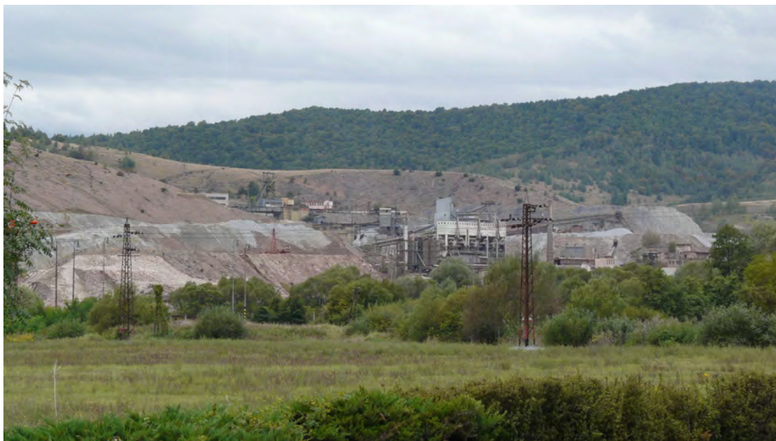
Obr. 30: Lokalita Lubeník. Pohľad z obce Lubeník na areál závodu. Foto od P. Bajto, 18.9.2008.
