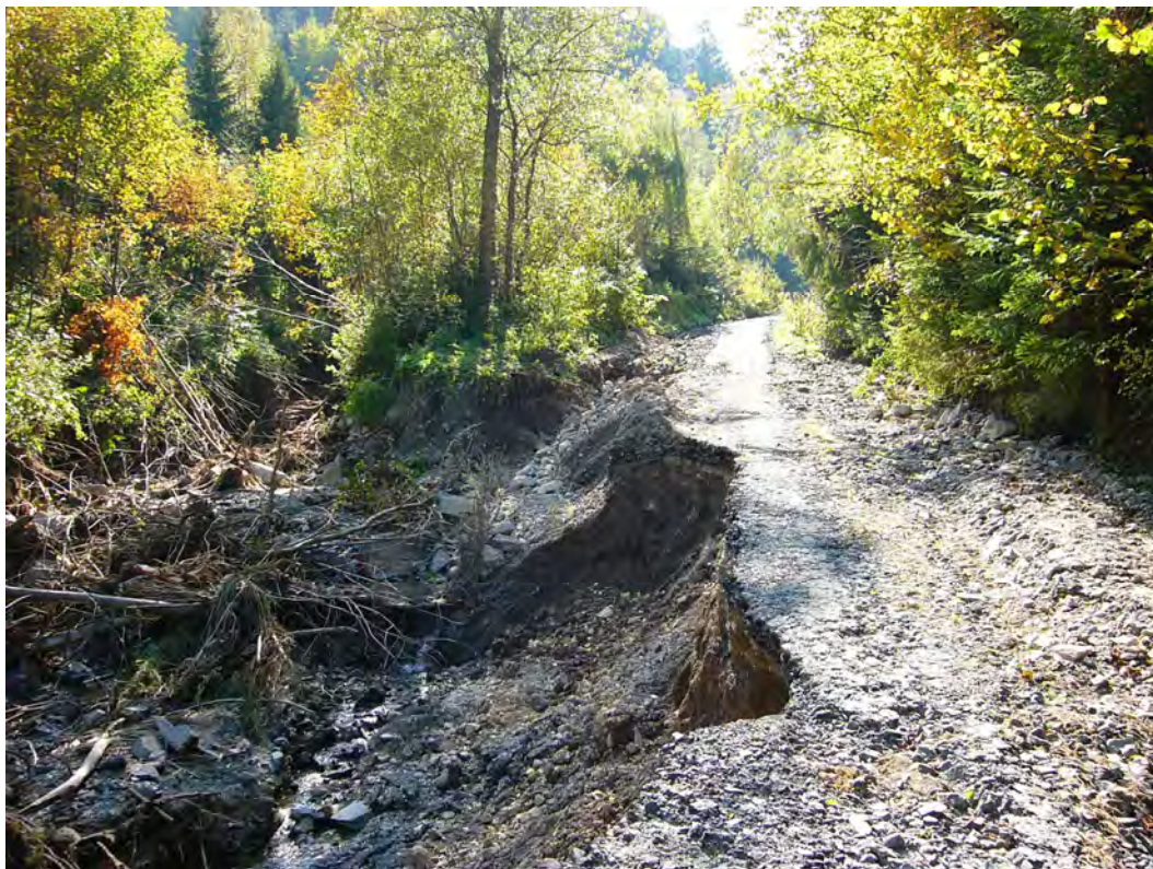
Obr. 102: Teplá ka nad Hornádom o následky prievalu banskej vody z Novej Ťolne. Erózia pôvodného koryta potoka pod Ťolnou a destrukcia vozovky. Foto: P. Baláfi, 2.10.2008.
