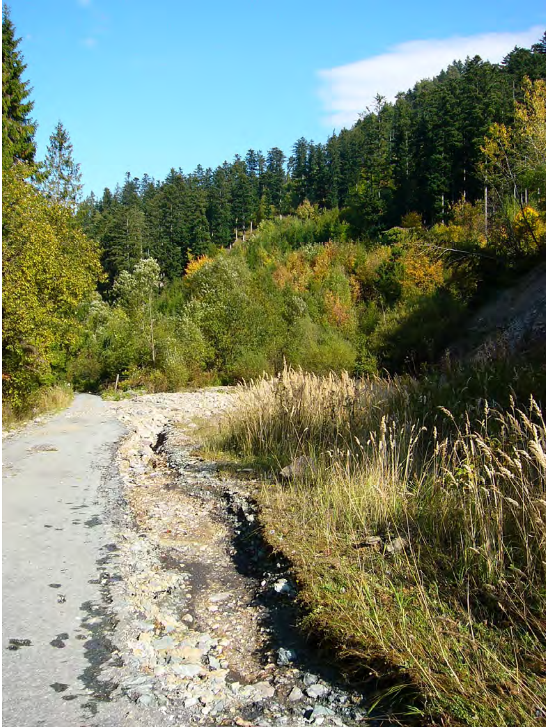
Obr. 99: Teplá ka nad Hornádcom o následky prievalu banskej vody z Novej -tôlne. Erózia dna doliny pozdĺž asfaltovej cesty a nízke polofnenej haldy (na pravej strane). Foto: P. Baláfi, 2.10.2008.
