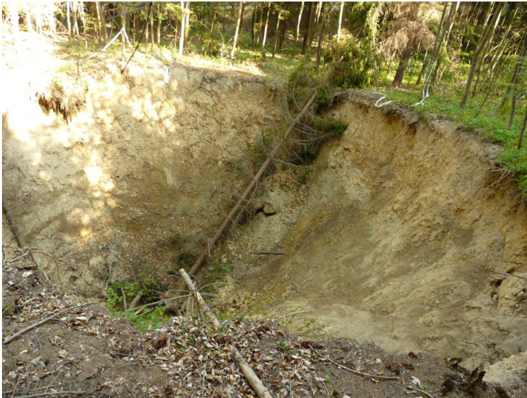
Obr. 109: Teplá ka nad Hornádom o následky prievalu banskej vody z Novej Ťolne. Kráterovitý zával nad Novou Ťolnou o pohľad zo Z. Priemer krátera 15 m, hĺbka 8-10 m. Foto: P. Bajto, 3.5.2009.
