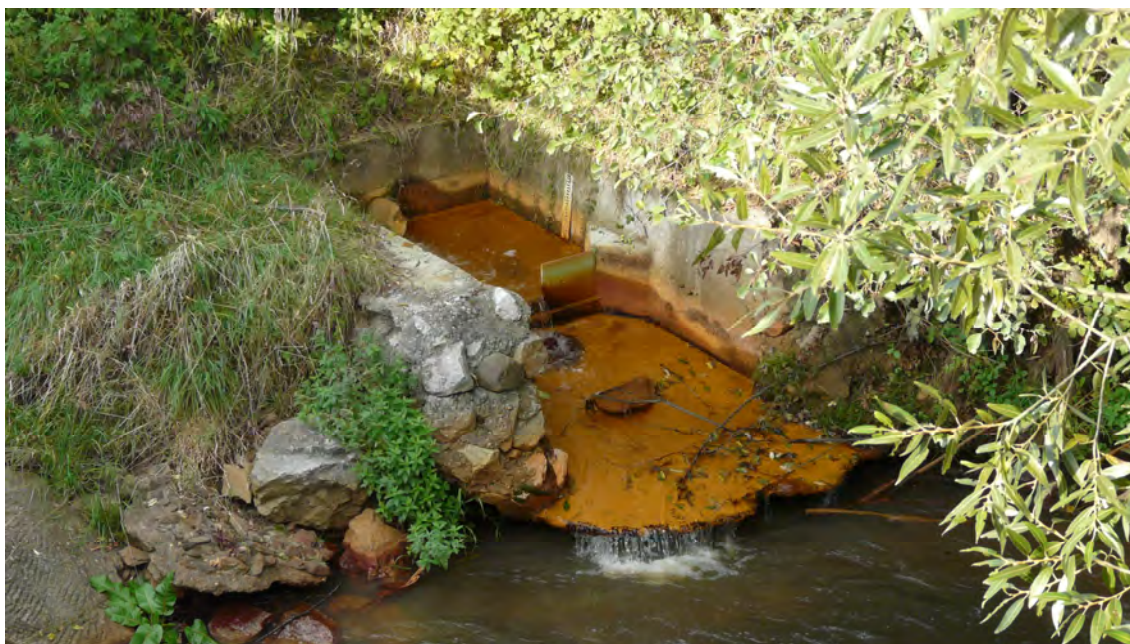
Obr. 76: Lokalita Rofl ava. Výus odpadového potrubia z Dopravného prekopu s merným prahom do rieky Slaná. Foto P. Bajto-, 18.9.2008.
