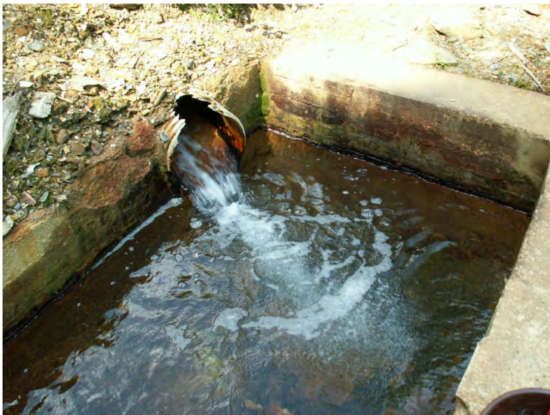
Obr. 55: Lokalita Smolník. Detail merného objektu banskej vody –achty Pech. Foto: P. Bajto–, 30.6.2008.
