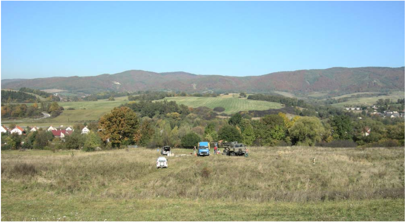
Vítanie a vstrojenie inklinometrického vrtu KI-1
