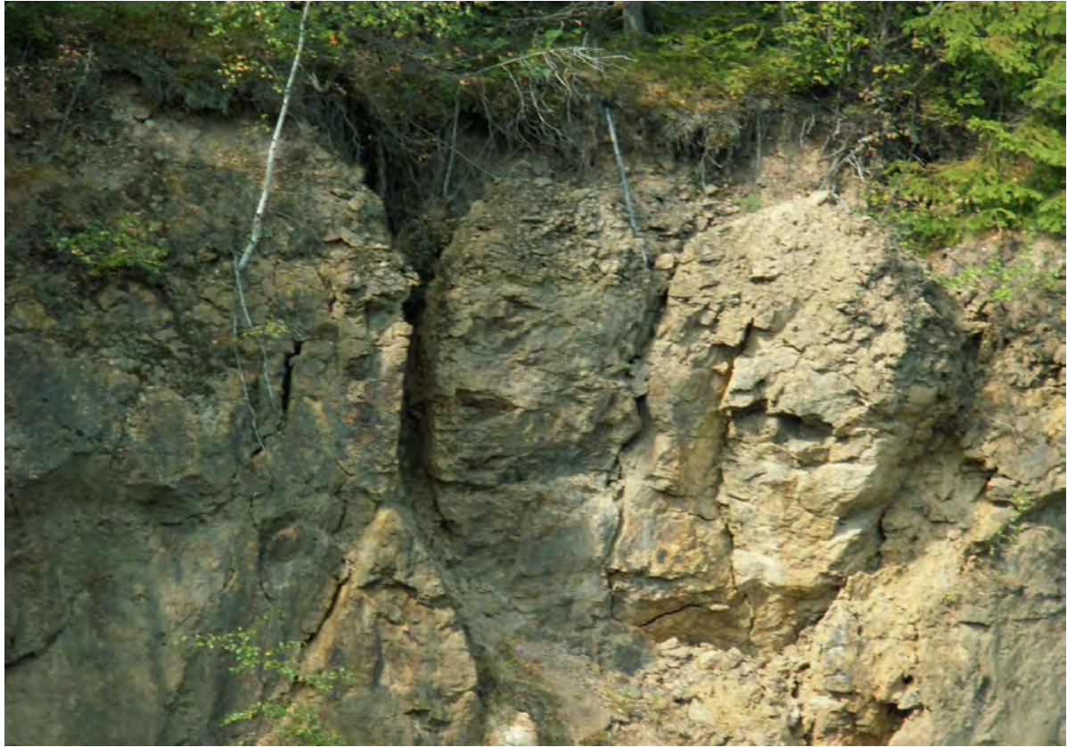
Foto č. 3a: Detail aktívnej ťahovo-poklesovej trhliny
