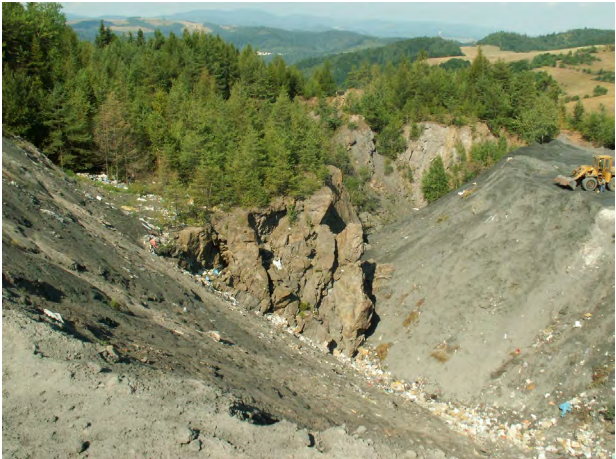
Foto č. 1: Postupné zasypávanie závalu odpadovým materiálom
