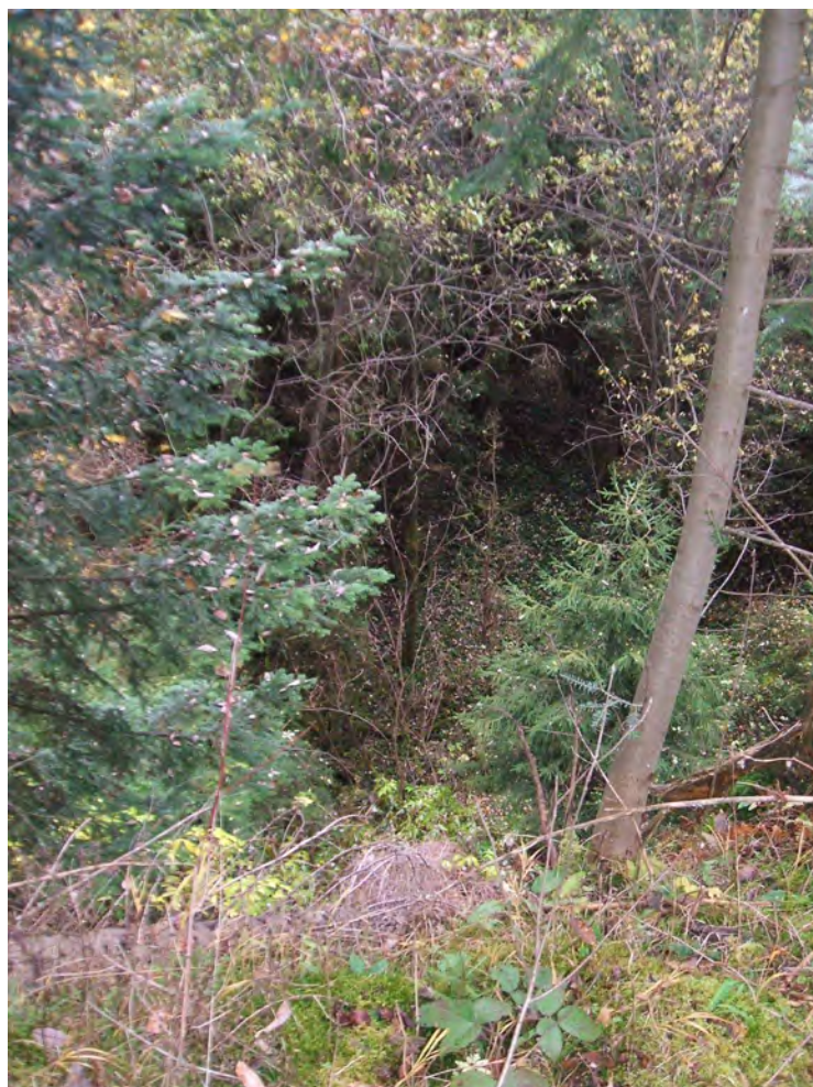
Foto č.4 prevažná časť závalu je pokrytá vegetáciou
