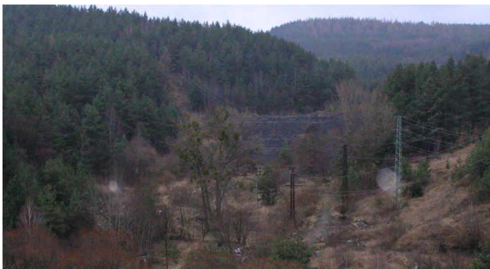
Obr. 3.3 Pohľad na hrádzu odkaliska
