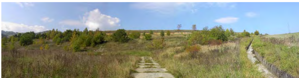
Obr. 29 Pohľad na hrádzu odkaliska
