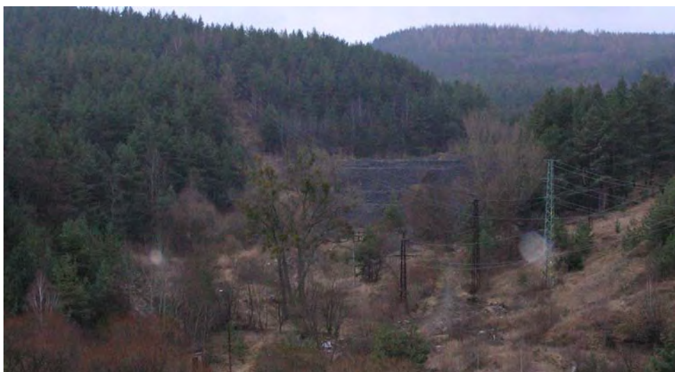
Obr. 28 Pohľad na hrádzu odkaliska
