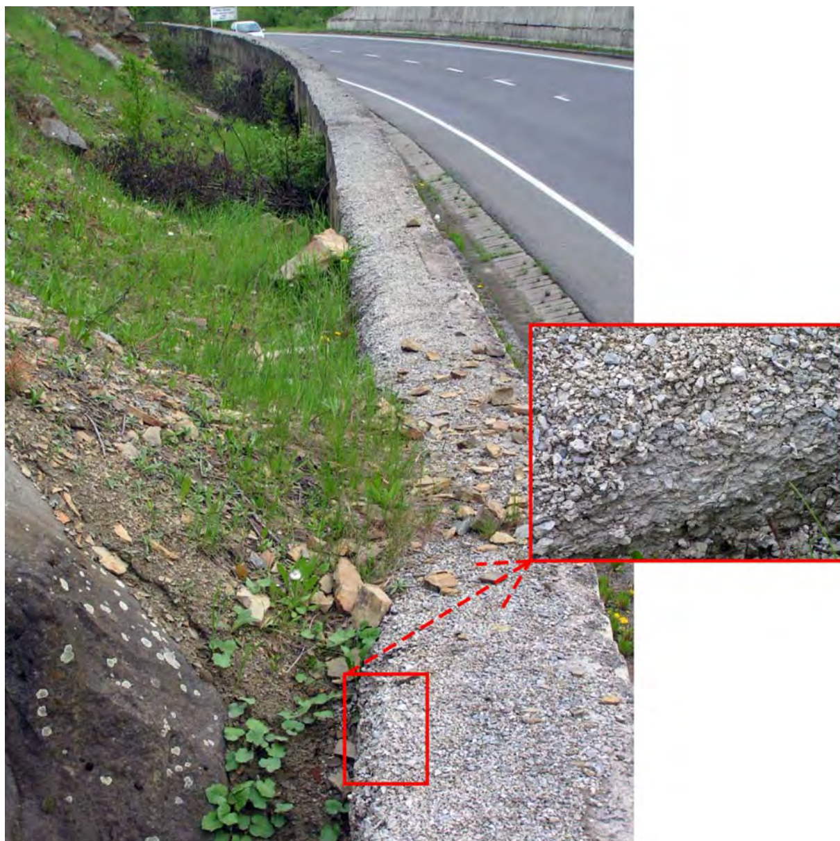
Obr. 2.1.75: Pokračující rozpad záchytného múra na lokalite Demjata
