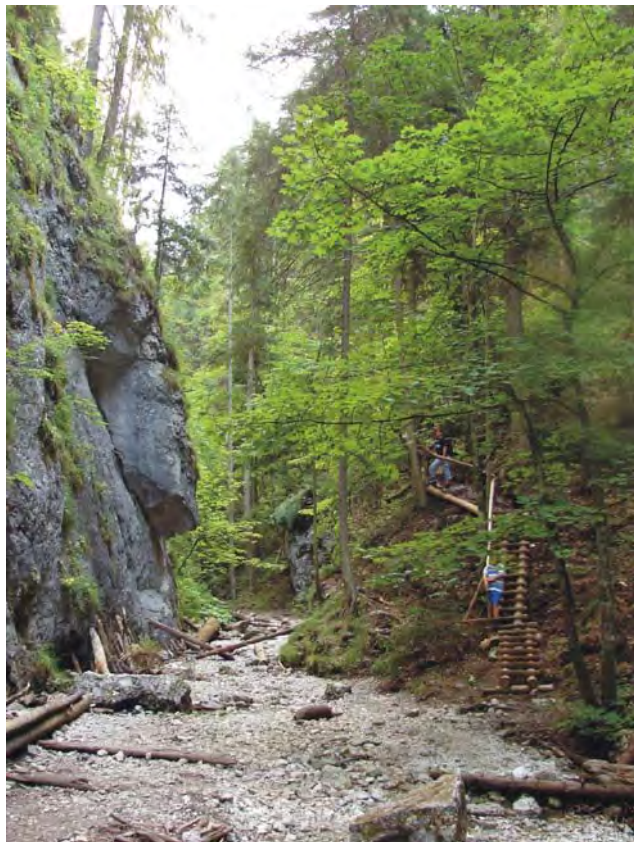
Obr. 2.1.79: Preloženie turistického chodníka mimo potenciálne nestabilný skalný blok na lokalite Suchá Belá.
