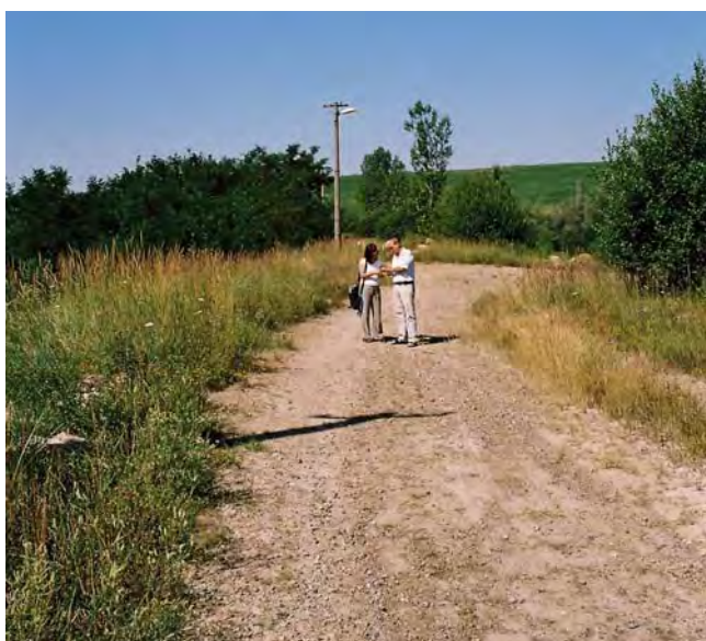
Obr. 11 Koruna základnej hrádze odkaliska
