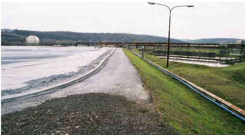
Obr. 8 Pohľad na rekonštruované nádrže na dočasné ukladanie vápenných kalov
