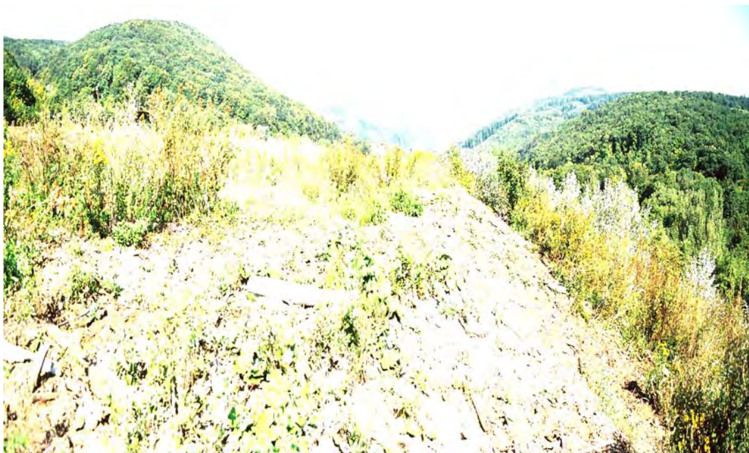
Obr. 1 Koruna základnej hrádze odkaliska
