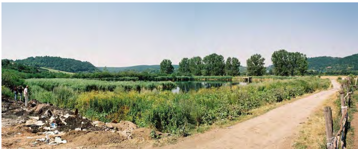
Obr. 5 Nevyhovujúci a neupravený technický stav nádrží
