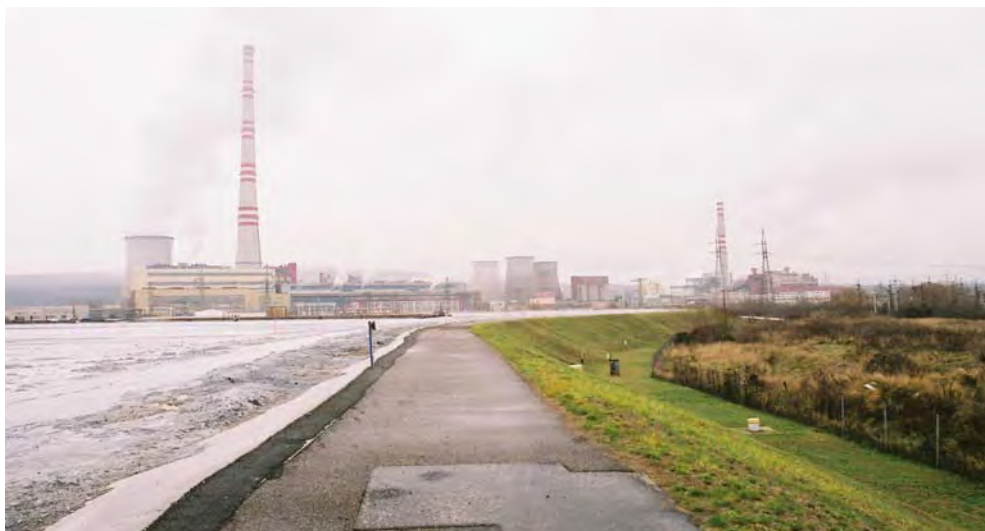
Obr. 7 Pohľad na hrádzový systém nádrží (po obvode monitorovacie objekty)
