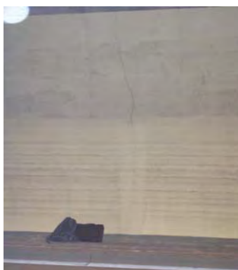
Obr.9.4. Trhlina vo vnútri tunelovej rúry únikovej štôlne tunela Branisko (cca 300 m od východného portálu) a namerané posuny pozdĺž zlomu
