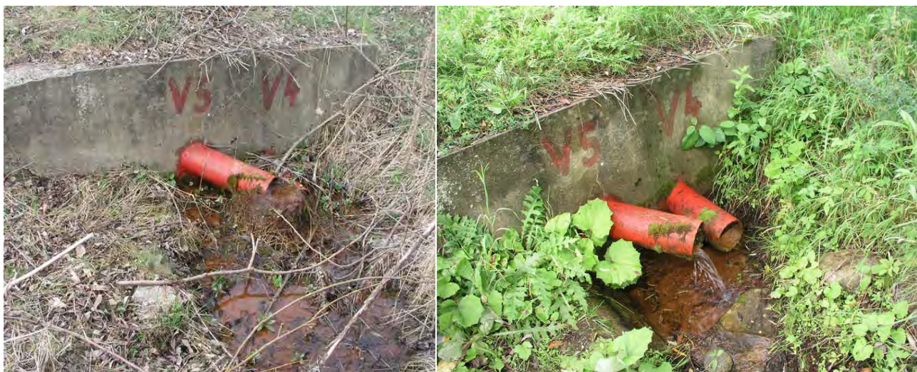
Obr. 2.1.49: Ústie horizontálnych vrtov V-4 a V-5 pred a po očistení
